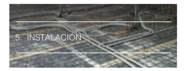
LAS INSTALACIONES DE REDES DE AGUA POTABLE DEBEN INSTALARSE DE ACUERDO A LO INDICADO EN LOS PLANOS Y ESPECIFICACIONES TÉCNICAS, UTILIZANDO MATERIALES AUTORIZADOS POR LA SISS, CONSIDERANDO NORMAS QUE RESTRINGEN EL USO DE ALGUNOS MATERIALES Y SIGUIENDO LAS RECOMENDACIONES DE INSTALACIÓN DEL FABRICANTE.
