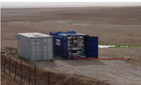
La instalación típica requiere de una plataforma nivelada de grava compactada o de hormigón. Todos los equipos incorporan tecnología Bluetooth para conectarse al sistema de control mediante aplicación Android y chequear su funcionamiento. Adicionalmente, los equipos pueden ser suministrados con sistema de mensajería a teléfonos móviles para monitoreo de funcionamiento. Todos los equipos Biokube son de bajo consumo eléctrico y alta confiabilidad. Requiere conexión eléctrica de 340 V.
