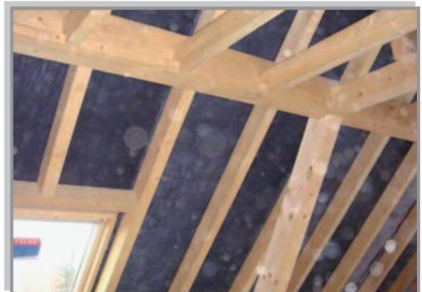
Con el fin de evitar los posibles puentes térmicos generados por las cerchas o vigas de la techumbre, el aerogel puede instalarse mediante cintas adhesivas de doble faz sobre cada una de ellas.
