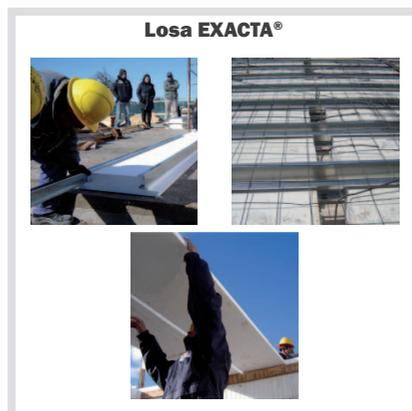
**Placa exterior EXACTA®, con cámara de aire**
