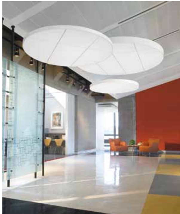
Figura 15. Cielo falso tipo isla.
