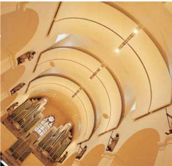
Figura 13. Cielo con placas curvas.
