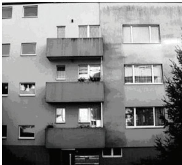
Figura 10.2. : Vista de edificio, cuyo sector derecho ha contado con aislacion termica por cerca de 1 año.
