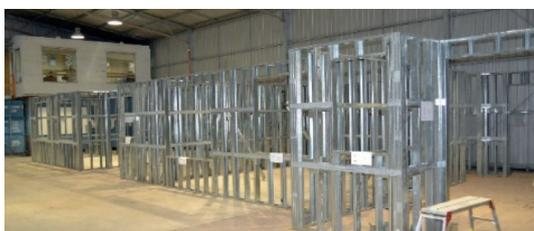
En Puerto Montt, Axis cuenta con un Taller Centralizado de Prefabricados (TCP), donde se construyen muebles, muros, losas y cerchas prefabricadas de metalcón para nuestros proyectos de la zona. En el TCP se fabrican muros de metalcón que incluyen las planchas de OSB y ventanas cuando se requieren. Tener un lugar para prefabricar permite un mejor aprovechamiento y optimización de recursos, lo que genera menos residuos.
