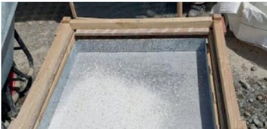
Mediante una máquina chipear que pertenece a Axis, los trabajadores adaptaron una mesa de madera como soporte y colocaron un contenedor abajo del soporte, el cual recibe el yeso-cartón molido. Esto permite reducir considerablemente su volumen, lo que significa ahorrar en transporte y disposición final. Pero además de eso, la mayor ganancia es volver a darle uso a un residuo que prácticamente no tiene salida para su reciclaje.
