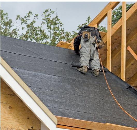
Súper Filtro Volcán es una barrera de humedad, que se usa bajo revestimientos de fachada, como Siding de fibrocementos o PVC, placas en base a cemento, placas en base fibro-yeso, madera, etc. Presentación rollo de 1,5 x 25mt = 37,5 m<sup>2</sup>.
