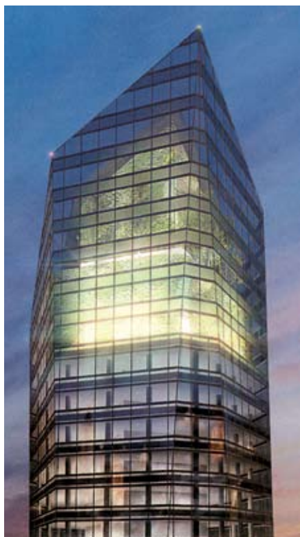
TORRE CRISTAL. En el último piso se ubica un jardín de invierno de 40 m de altura, el cual se podrá observar desde distintos puntos de Madrid.
