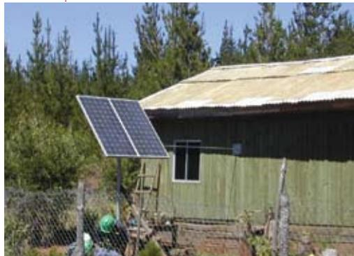
Los paneles fotovoltaicos, conformados por celdas de silicio, son los principales responsables del proceso de transformación. En esta línea, ISENER ofrece los paneles Millenium, que poseen una cubierta exterior de vidrio
