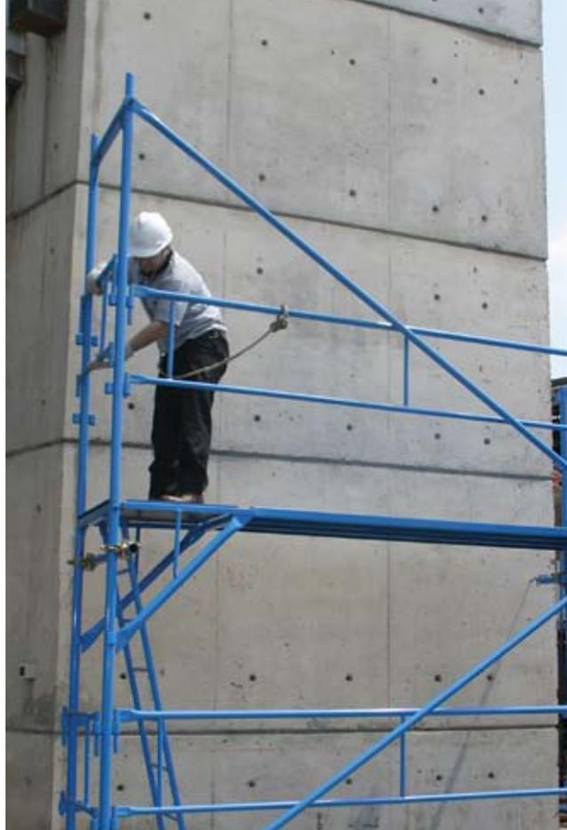
En las faenas en altura las labores más riesgosas se observan en el montaje y desmontaje incorrecto de las superficies de trabajo, y en la excesiva separación entre el andamio y las fachadas.
