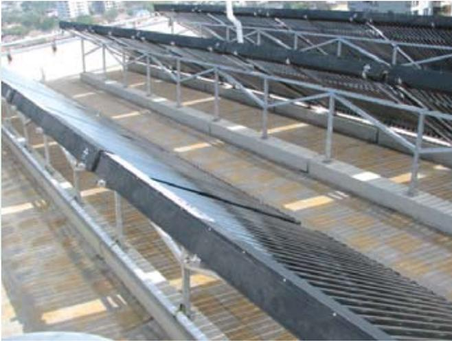
El sistema solar térmico del edificio Al Ras. Uno de los edificios pioneros con esta solución en Santiago. La experiencia sufrió modificaciones como el ajuste del cálculo de los litros de agua diaria requeridos por el edificio.
