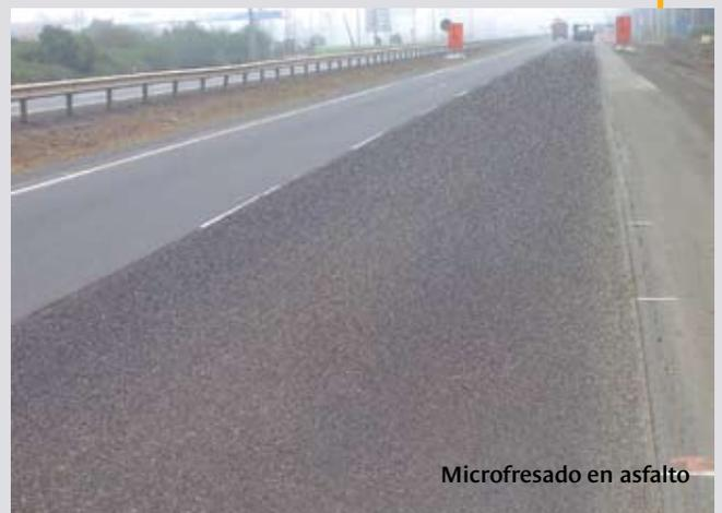
Microfresado en asfalto
