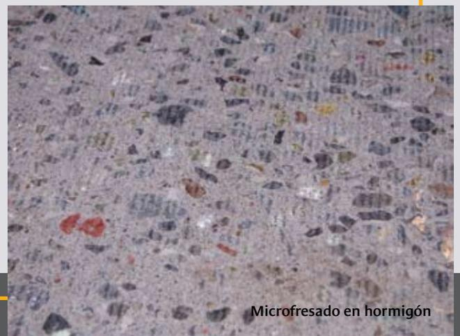
Microfresado en hormigón
