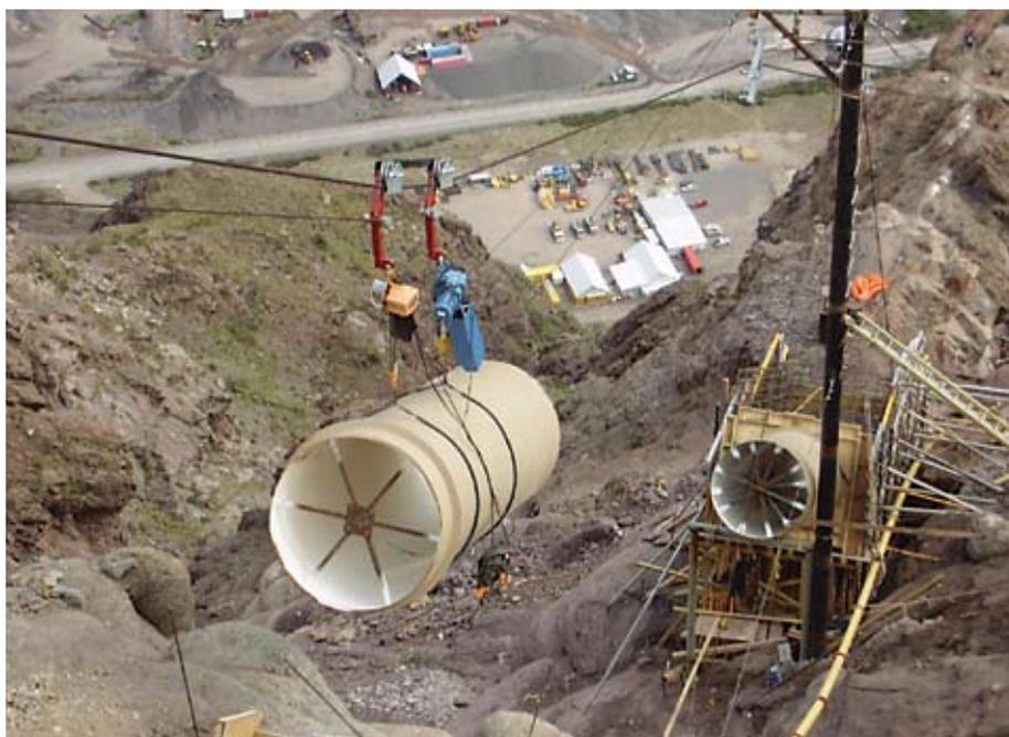
de hormigón, que empotran adecuadamente la tubería en la roca. Se colocan cuando por el caudal y la presión del agua se producen fuerzas en los cambios de dirección, tanto vertical como horizontal. “La tubería queda al interior de los machones, que se complementan con sillas, encargadas de resistir el peso de la tubería y del agua de manera vertical”, indica Jaime Guzmán, jefe del proyecto de diseño de las Obras Civiles de Ingendesa.
