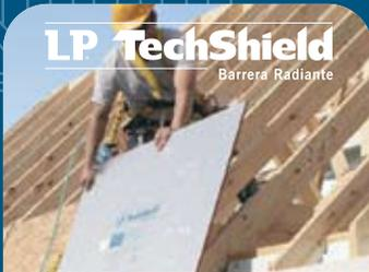
Barrera de radiación basada en el tablero estructural LP OSB con cara de aluminio.
