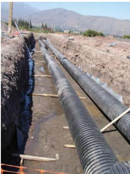
**Esquema del sistema de Bioclima. En verano el aire se inyecta a las distintas áreas de producción (21°). En invierno el aire frío se incorpora a los productos terminados y máquinas sopladoras, en tanto que el caliente al proceso de calefacción. Abajo los ductos del sistema, a 3,5 metros de profundidad.**
