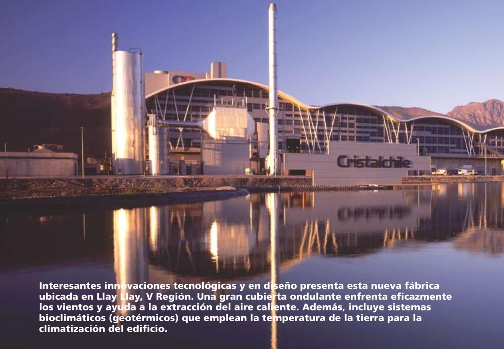
Interesantes innovaciones tecnológicas y en diseño presenta esta nueva fábrica ubicada en Llay Llay, V Región. Una gran cubierta ondulante enfrenta eficazmente los vientos y ayuda a la extracción del aire caliente. Además, incluye sistemas bioclimáticos (geotérmicos) que emplean la temperatura de la tierra para la climatización del edificio.
