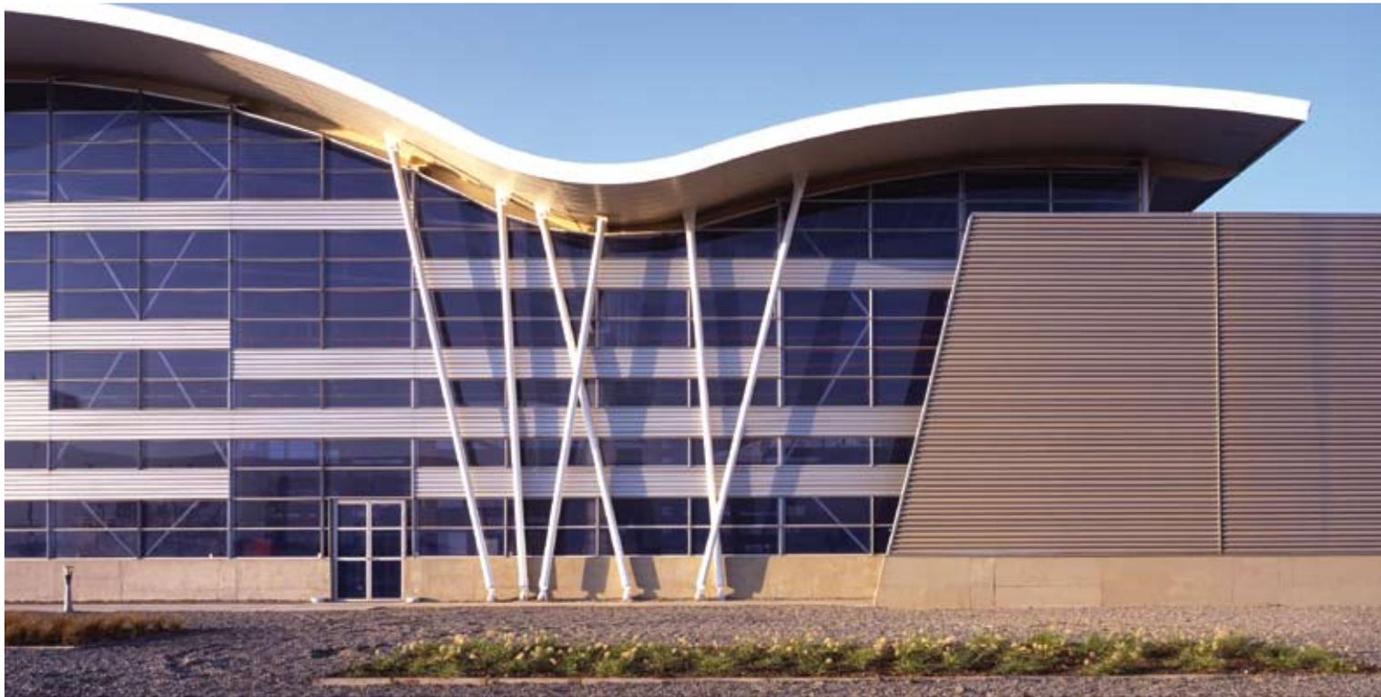
**El detalle de la cubierta curva se adoptó por ser el mecanismo más apropiado para disminuir el efecto del viento. Los pilares metálicos colocados en forma oblicua y cruzados otorgan profundidad al edificio.**
