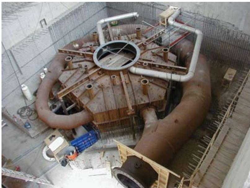
Montaje de la turbina Pelton de seis chorros. El tubo que gira alrededor se llama alimentador o caracol y es el que inyecta el agua. Al lado, el montaje de una torre de alta tensión.
