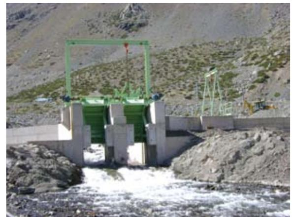
Construcción del sifón que empalma con el primer túnel. A la derecha, para su protección, el embalse posee una entrada de hormigón con un sistema de caída que disipa la energía. Al lado la bocatoma Juncalillo, que tiene dos compuertas para el paso del agua.
