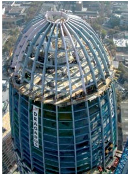
Estructura metálica empleada en la cúpula.
