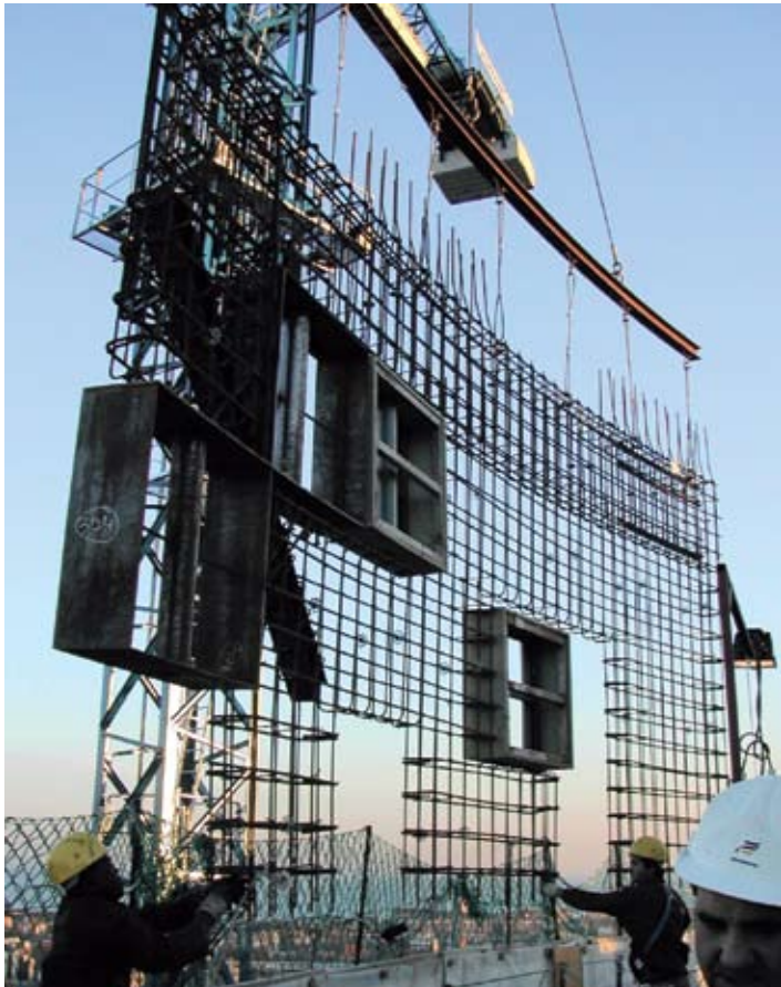
Elevación de enfierradura industrializada, que incluye marcos de ventanas.
