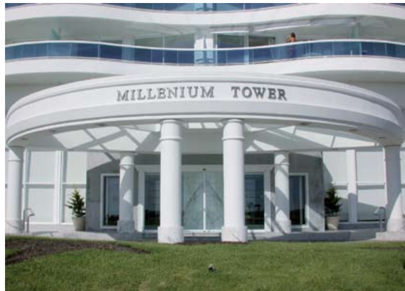
Obra que incluye detalles de lujo. Constructora Tecsa S.A. en Uruguay.
