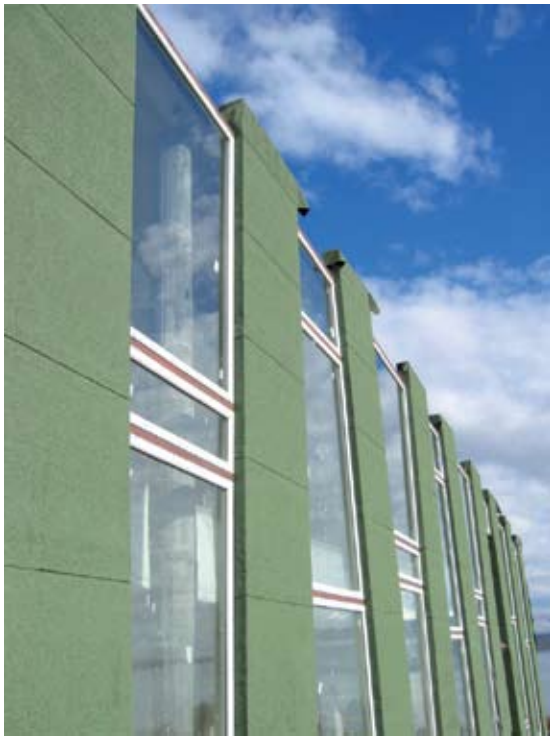
Detalle del ángulo que van tomando las ventanas y cómo van insertas en los paneles de madera. Abajo, parte de la logística de la obra, en la que el clima fue el enemigo natural de la faena.
