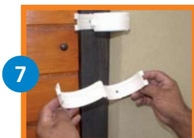
7 Utilice 2 abrazaderas para cada tubo de bajada. Éstas deben ser fijadas con tornillos.
