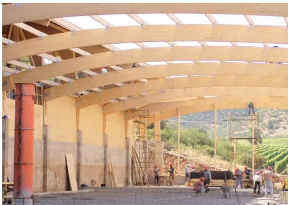
**La estructura del techo está hecha de madera encolada laminada, la que se ensambla a modo de mecano por medio de conectores de acero galvanizado.**
