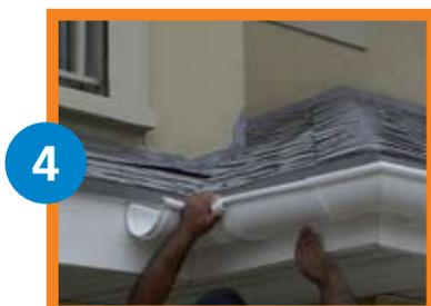
4 Comience con la instalación de la canaleta ubicándola sobre los soportes. Primero, el borde interno y luego, a presión los bordes externos correspondientes. Si es necesario instale las esquinas en los extremos de las canaletas.
