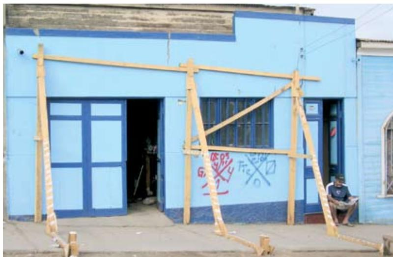
**Solución provisoria: estructura de madera que evita el derrumbe de la fachada de una vivienda en el centro de Tocopilla. Soportó fuertes réplicas.**
