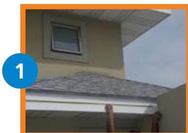
1 Medir en el tapacán la superficie a cubrir con canaletas y determinar dónde quedará instalada la o las bajadas de agua (generalmente se ven mejor cerca de las esquinas).
