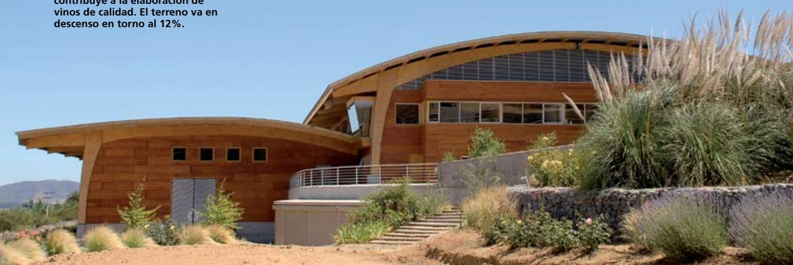
“La propuesta arquitectónica planteó un proceso de vinificación que se logra por terrazas que se disponen en tres niveles, las que permiten a través del proceso gravitacional, un flujo pasivo sin requerimiento de energía externa.
