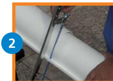
2 Seleccione los metros de canaletas a utilizar según la medición de la superficie del tapacán a cubrir. En el caso de que exista un largo de canaleta inferior a 3 metros, ajuste la longitud utilizando la sierra. En este caso elimine las rebabas con el cuchillo.
