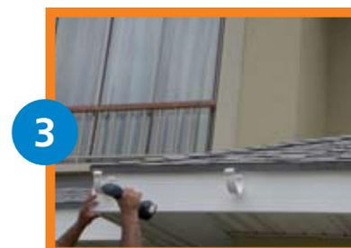
3 Instale los soportes en el tapacán. El espacio entre cada soporte no deberá superar los 90 centímetros. La inclinación entre el punto de inicio y el final de la canaleta, deberá ser de un 0,5%.
