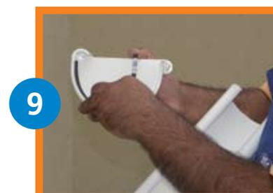
9 Finalmente coloque las tapas en cada extremo de la canaleta. Para el sellado de tapas, esquinas y uniones se utiliza el anillo de sello de goma Aquapluv.
