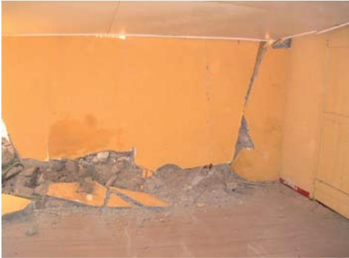
El sistema constructivo predominante en la zona se basa en hormigón pobre con madera y mallas de alambre, sin fierros y con elementos sin conexión.
