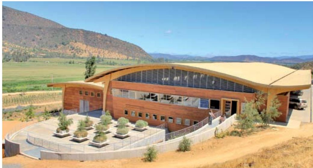
sobre ellos, a modo de mecano, se encuentra la estructura de madera laminada encolada en base a sistemas de ensamblaje tradicionales.
