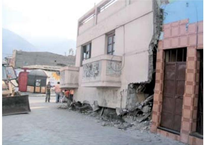
**Un caso emblemático: el primer piso a centímetros del suelo. Al lado, la maquinaria espera iniciar la demolición.**
