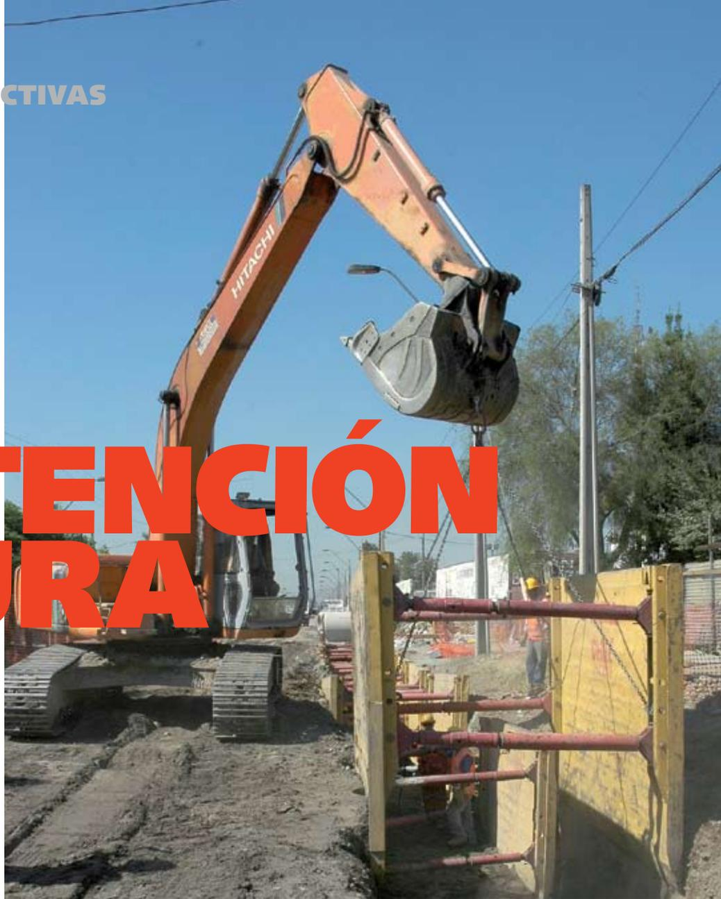
**L**A ENTIBACIÓN CONSTITUYE un sistema de contención provisional de paredes de excavaciones empleado en la ejecución de obras subterráneas tales como instalaciones de tuberías, cajones, cámaras, plantas elevadoras, estribos y cepas de puentes, entre otros. Hasta hace algunos años, el sistema de sostenimiento utilizado para estas faenas consistía en entibaciones de madera, que al momento de ser instalado tenía un alto riesgo de derrumbes.
