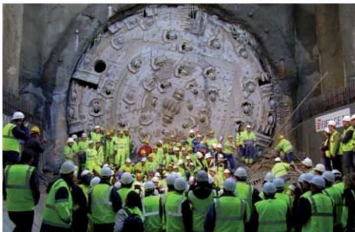
El 23 de noviembre de 2007 culminó exitosamente la excavación del túnel Pertús.
