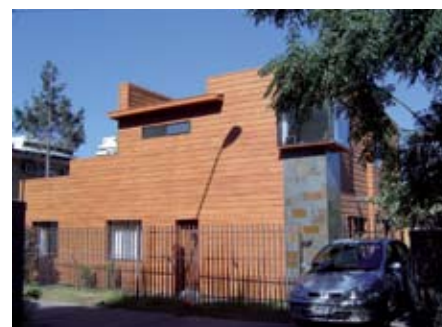
4) Acondicionamiento térmico de muros perimetrales finalizado.
