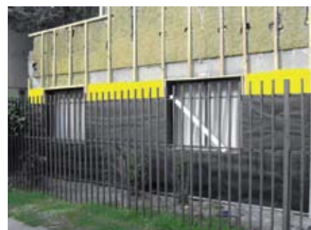
2) Instalación de lana de vidrio AislanGlass de 40 mm de espesor y fieltro asfáltico 15 libras.
