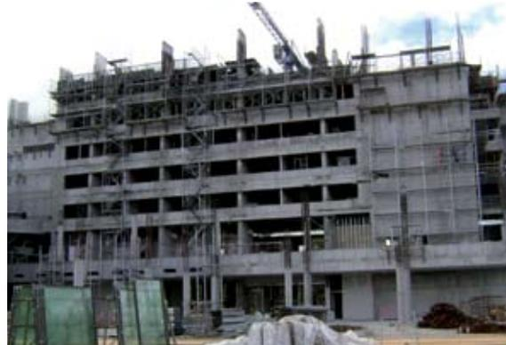
rededor de 2.000 m<sup>2</sup>-, se ejecutó una losa sobre vigas postensadas en la mitad de su superficie y sobre vigas tradicionales en el área restante. En restaurantes y boulevard hay losas y vigas postensadas en los dos niveles. En el hotel se emplean losas con capitel y postensadas desde el tercer al octavo nivel. El casino y los estacionamientos también están contruidos con vigas postensadas.
