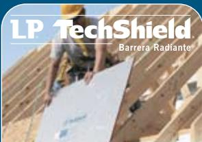
Tablero estructural OSB con barrera radiante de aluminio, que refleja el 97% del calor.
