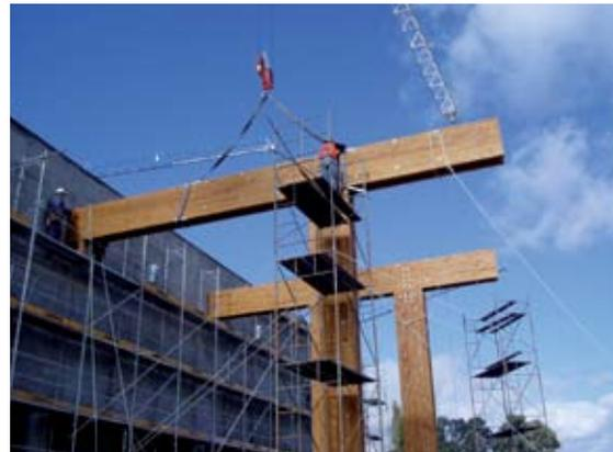
**Paso a paso de la instalación de la marquesina. La madera laminada llega lista a obra y las piezas se ensamblan a modo de mecano. La marquesina va dispuesta a lo largo de toda la fachada del casino y hotel.**
