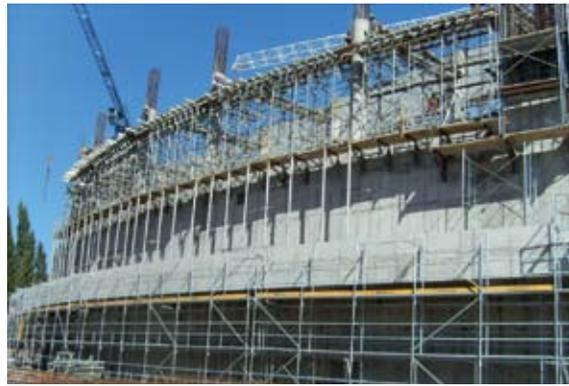
Obra gruesa del casino y del hotel. El salón de juegos es curvo y contempla tres pisos en doble altura. Abajo, el hotel será de seis pisos convencionales cuya fachada principal mira hacia el río Rahue. En ambos edificios se aplicó un sistema mixto de losas postensadas con hormigón tradicional.
