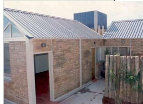
Luego de las correspondientes inspecciones de medidas y uniones en fábrica se transportan a obra, en donde se procede a su montaje definitivo, incorporando las piezas transversales que vinculan los pórticos entre sí. Estas uniones se realizan mediante soldadura eléctrica. La envolvente consiste en una albañilería de fácil colocación debido a que la estructura metálica provee de todas las líneas necesarias para hacer una prolija faena.
