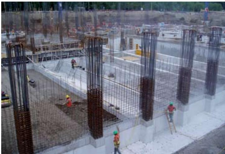
**Para asumir el peso del edificio las fundaciones están hechas con cámaras de peso, las que están fabricadas por un radier de 30 cm de hormigón, luego 1,6 m de altura de material de relleno y finalmente una capa superior de radier afinado.**
