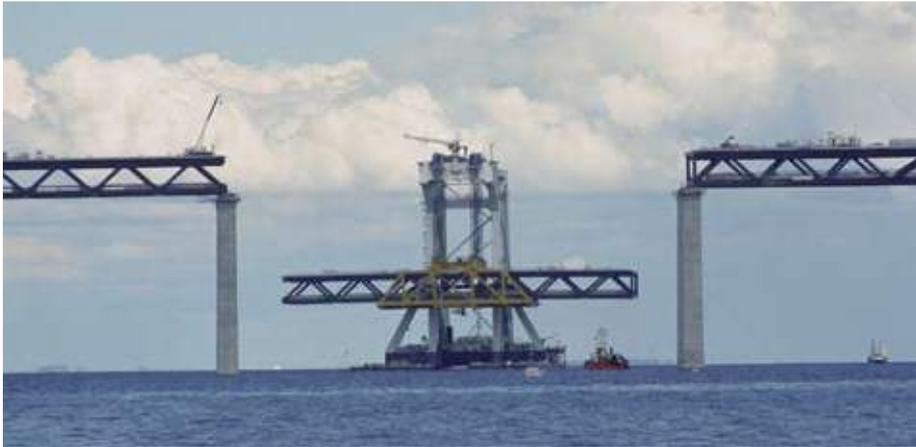
Una grúa con capacidad de carga de 9.990 t realizó el montaje de los elementos prefabricados de los puentes de aproximación al viaducto colgante.
