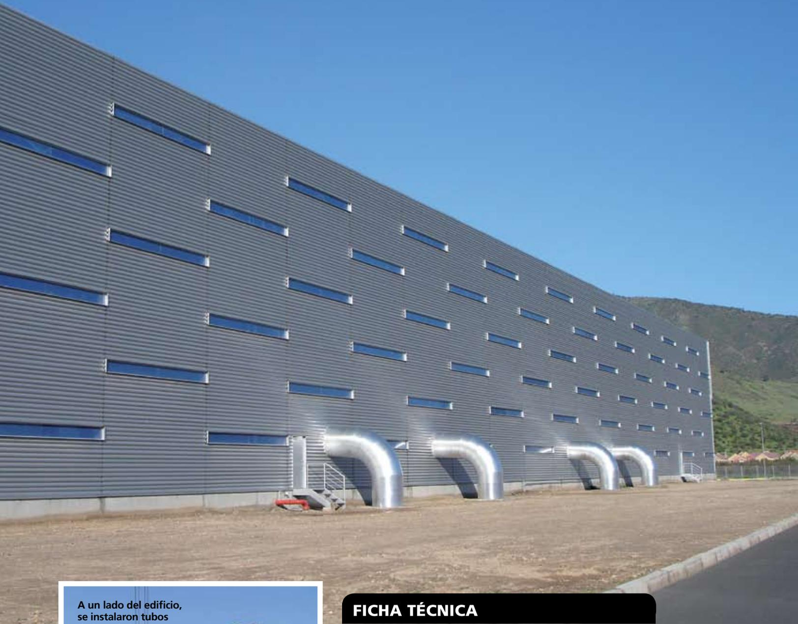
A un lado del edificio, se instalaron tubos de hormigón de 1,20 m de diámetro que emergen con una materialidad de aluminio.
