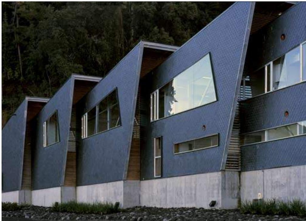
Se observan celosías de madera de pino que permitían la renovación de aire y evitaban la condensación.
