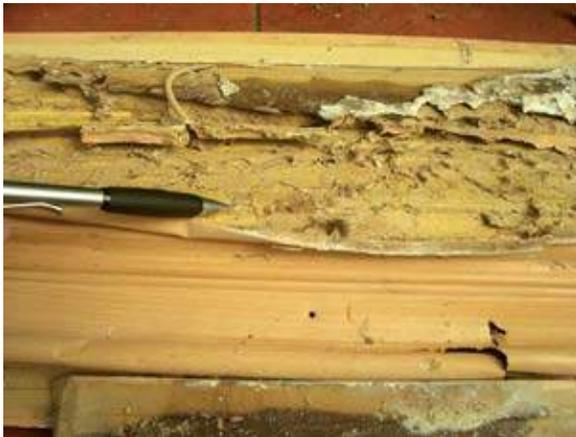
**Daños ocasionados por la termita subterránea en guardapolvos y pisos flotantes foto-laminados.**
