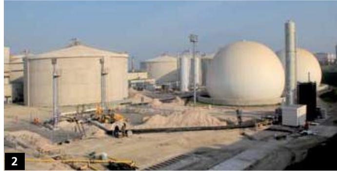
A nivel constructivo los anillos de concreto de los digestores se armaron en tres etapas. “Teníamos dos juegos de moldajes, cuando se completaba una etapa, pasábamos a la siguiente. Trabajamos con una secuencia muy rápida. Las trepas de moldaje eran de tres metros. Mientras en un digestor hacíamos una losa, en el siguiente estábamos en el techo”, comenta Burstein.
