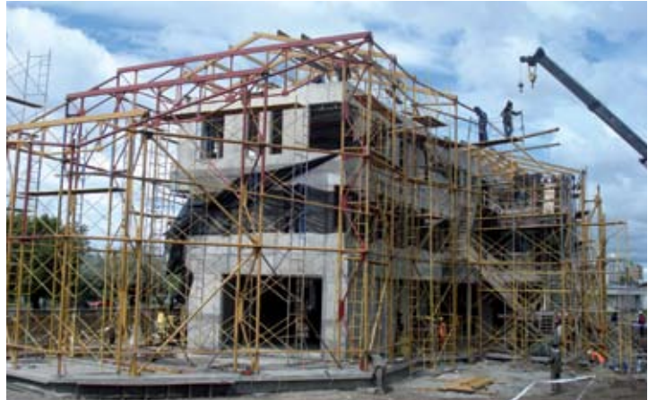
Arriba: Lógica constructiva. Se aprecia, de adentro hacia afuera: el edificio, la estructura metálica y los andamios.
