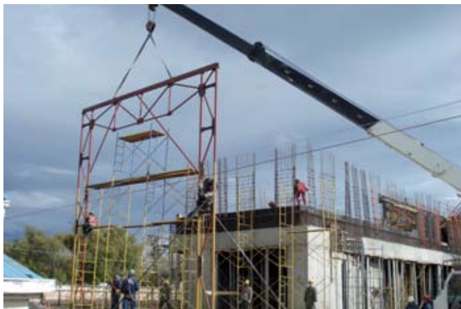
A medida que el edificio de hormigón crecía, paralelamente lo hacía la estructura metálica que recibe a la de aluminio.
