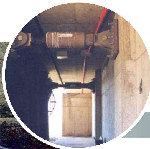
**Sobre las cepas del puente Amolanas se instalaron dos amortiguadores viscoelásticos en los estribos que actúan absorbiendo las vibraciones sísmicas.**
