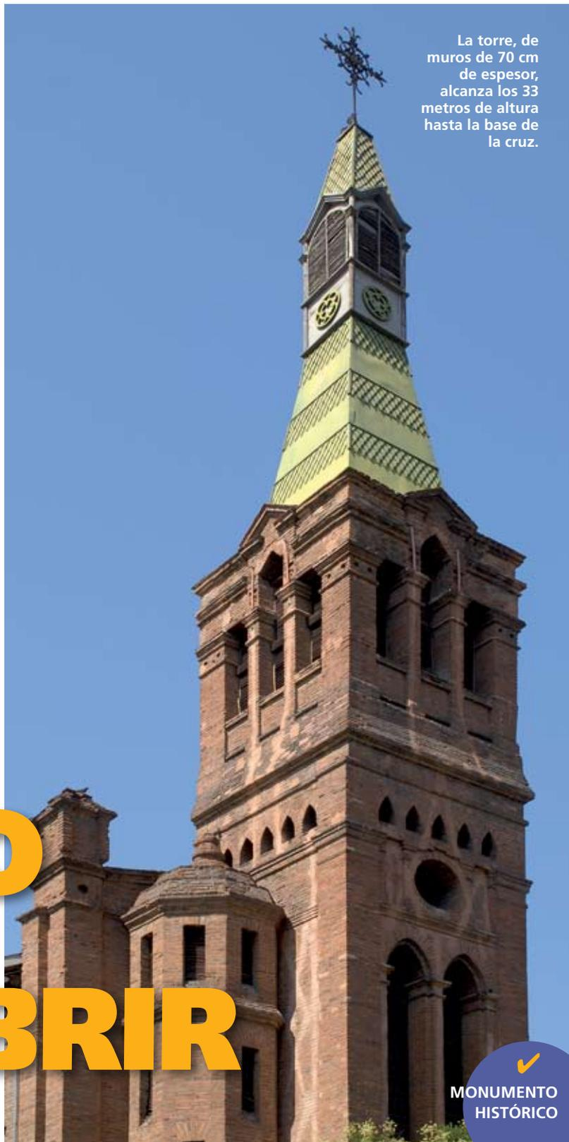
La torre, de muros de 70 cm de espesor, alcanza los 33 metros de altura hasta la base de la cruz.
