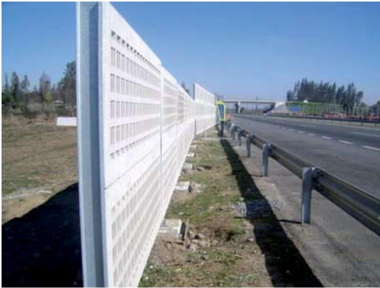
BARRERA DE HORMIGÓN ARMADO
