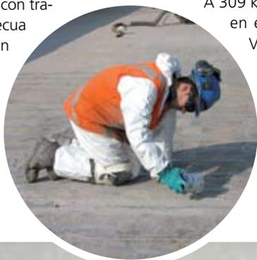
**Barra de polímero reforzado con fibras de carbono. Arriba: Ranurado y aplicación de époxico para la instalación de la pletina de fibra de carbono en el puente Centenario.**
