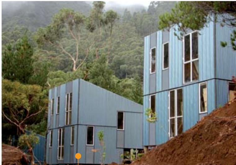
**8** Las viviendas terminadas permiten observar las ventanas de aluminio y el revestimiento exterior de acero microondulado. La irregularidad del terreno y la espectacularidad del entorno natural suman elementos adicionales al proyecto habitacional.
