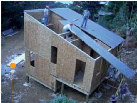
**7** Instalación de la cubierta compuesta por plancha metálica y aislante de poliestireno expandido (Instapanel y Nova Chemicals), que aportó rapidez en el montaje, resistencia a la estructura y aislamiento térmico. Una muestra de soluciones prefabricadas y de faenas de armado en seco.
