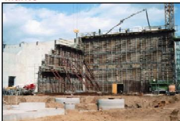
Sistema de moldaje industrial, en base a placa fenólica y bastidores de acero galvanizado, permite hormigonar grandes superficies, resistiendo altas presiones de hormigonado (hasta 8kN/m<sup>2</sup>), ideal para obras civiles
