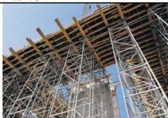
Sistema de encofrado de losas, en base a torres de 1x1 m. Cada torre soporta hasta 20kN, sin necesidad de arriostramiento para transmisión de cargas. Sólo 5 componentes livianos y maniobrables permiten un armado rápido y seguro, pueden ser transportadas por una grúa.
