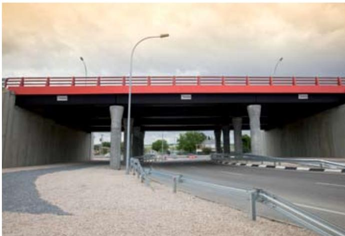
**Puente español construido con estructuras mixtas de hormigón y materiales poliméricos reforzados con fibra de vidrio y carbono.**
