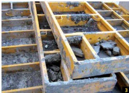
4. Desorden en obra. En la imagen se observan paneles de moldaje o piezas de unión, puntales e incluso una huincha de medir, entre medio de basura.
