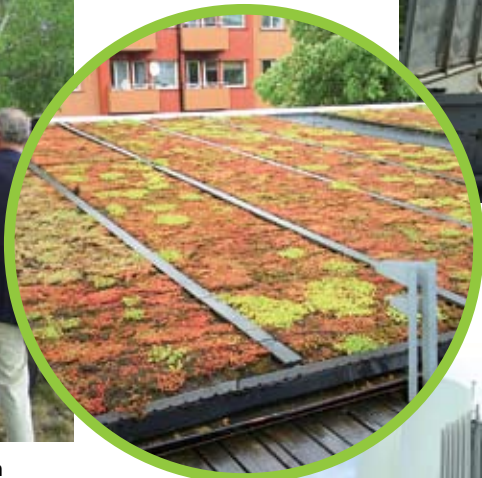
Los green roof o techos verdes absorben y filtran las aguas lluvias, las que luego son utilizadas para los inodoros.
