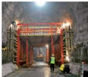
PERI VARIOKIT, TÚNELES MINEROS
