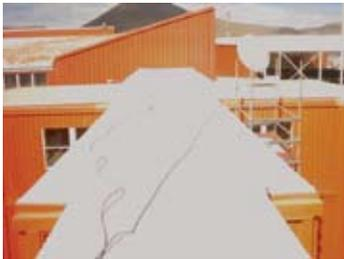
Se lanzó una membrana polimérica de PVC multicapa diseñada especialmente para impermeabilizar cubiertas y jardineras. Es inocua para plantas, resistente a microorganismos y a aguas ácidas. Posee una alta durabilidad, flexibilidad y estabilidad dimensional, además, se puede utilizar para lagunas artificiales, rellenos sanitarios y canales, destaca su proveedor.
