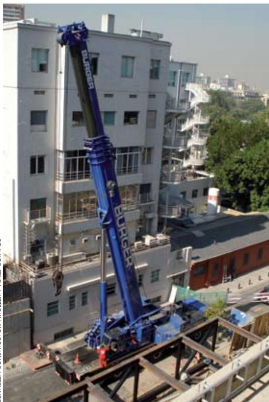
**Para levantar los puentes ya ensamblados se usó una grúa de alta capacidad de carga.**
