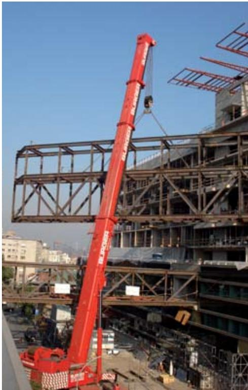
**El puente superior es una estructura doble que abarca los pisos 6° y 7°, cuya forma se asemeja a la de una "Z".**
