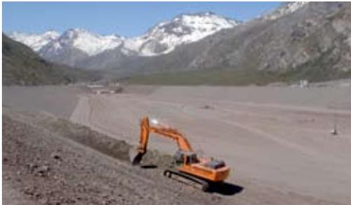
1,2 millones de m<sup>3</sup> (en la foto), que recibirá el agua de ambas bocatomas principales, con la que se espera reducir significativamente el área inundada, que se estima sólo alcanzará las 30 hectáreas. El recorrido termina en la casa de máquinas donde se genera la energía, y el agua se devuelve al río a través de un canal.
