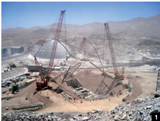
1. Montaje simultáneo del octógono y dos secciones prearmadas (octavos) del edificio. En la foto se aprecia la gigantesca excavación y las compuertas por las que cae el material acopiado.
