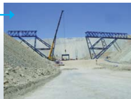
3. Una vez que la estructura queda estable, se procede a levantar la galería central.
