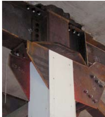
Protección de pilares en Mall Arauco Maipú, en base a planchas de fibrosilicato.
