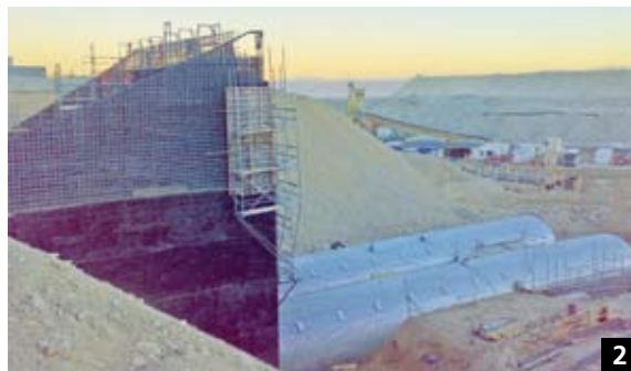
1. Montaje simultáneo del octógono y dos secciones prearmadas (octavos) del edificio. En la foto se aprecia la gigantesca excavación y las compuertas por las que cae el material acopiado.
