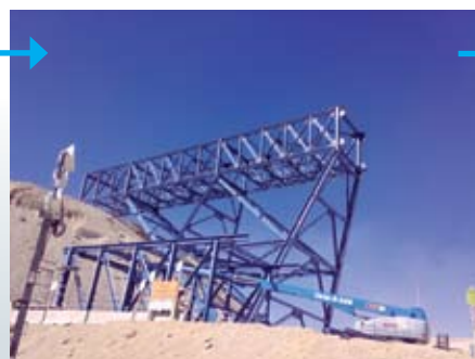
2. Atravesos. Se montan los tramos laterales sobre el talud.
