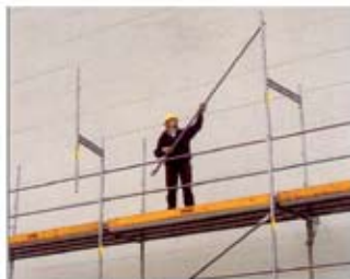
Sistema Peri UP 70/100 Andamio Fachada
