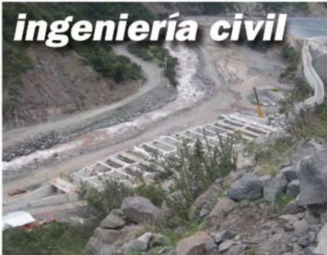
OBRA DESARENADOR AZUFRE HIDROELECTRICA LA HIGUERA
