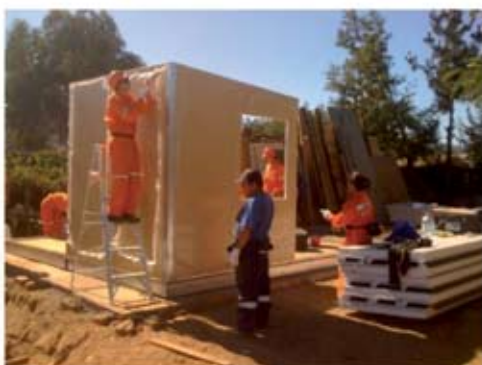
Primer proyecto de vivienda aislada en Quirihue, VIII Región. Se trata de una casa de 21 m 2 con paneles aislados Isopol.
