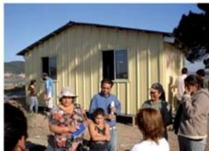
Primer proyecto de vivienda Metalcon en Caleta Tubul, a 20 km de Arauco. Consiste en un sistema habitacional de 19,1 m 2 , ampliable a 54 m 2 .
