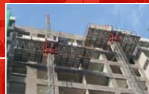
Plataformas de Cremallera (hasta 30 mts de ancho y 120 mts de altura)
