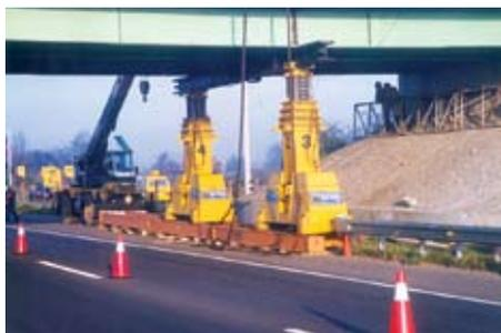
de en contacto directo con el concreto, que a su vez sirve para suplir pequeñas diferencias milimétricas que se pueden dar entre una viga y otra", explica Cerda. Las gatas se montan sobre tracks o carrileras de desplazamiento, sobre las cuales se trasladan en base a ruedas. El izado es preciso y a la vez sutil, lo que evita el efecto "péndulo" producido con las grúas convencionales. En próximas ediciones de Revista BIT se profundizará en la técnica y su aplicación en puentes y pasarelas.
