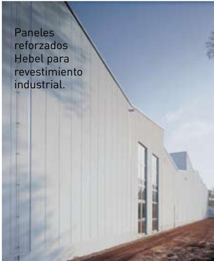
Paneles reforzados Hebel para revestimiento industrial.
