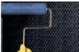
**5. Oprimir la lámina de fibra contra el saturante húmedo. Pasar rodillo acanalado para oprimirla contra la superficie. Aplicar una segunda capa de resina para permitir el encapsulado completo de las fibras.**
