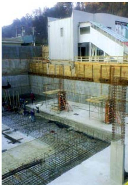
**Impermeabilización de la losa de fundación.**
