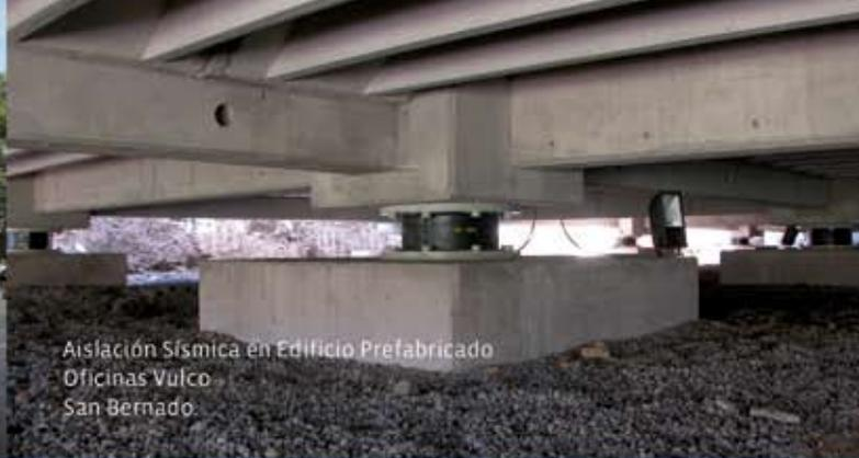
Aislación Sísmica en Edificio Prefabricado
