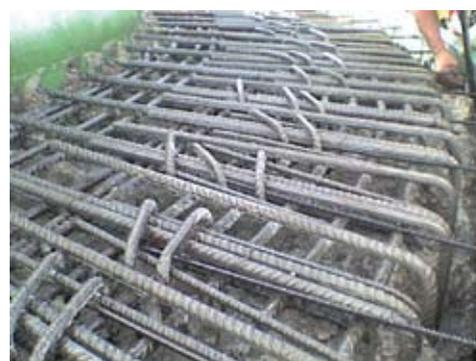
Aspecto final de la armadura tras Hidrodemolición.
