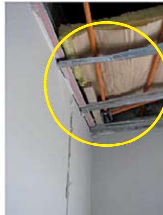
**Deterioro por fuerzas de compresión de los muros laterales, debido a que el cielo se encontraba fijo al perímetro y al distanciamiento inadecuado de los cuelgues.**
