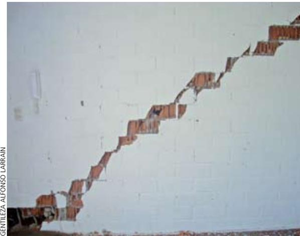
Una de las fallas recurrentes observadas en este terremoto, en muros de albañilería, fueron las grietas de corte.
