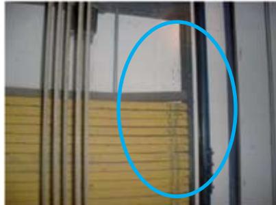
Desprendimiento de elementos del contrapeso que no contaban con sistemas antisísmicos
