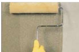
**1. Aplicar refuerzo MBrace® de BASF, utilizando un rodillo medio.**
