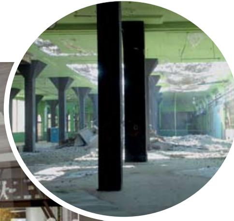
**El boulevard central del edificio industrial mantendrá la pilarización original de la estructura, sin embargo, algunos sectores se demolieron para dar paso a los estudios de televisión.**
