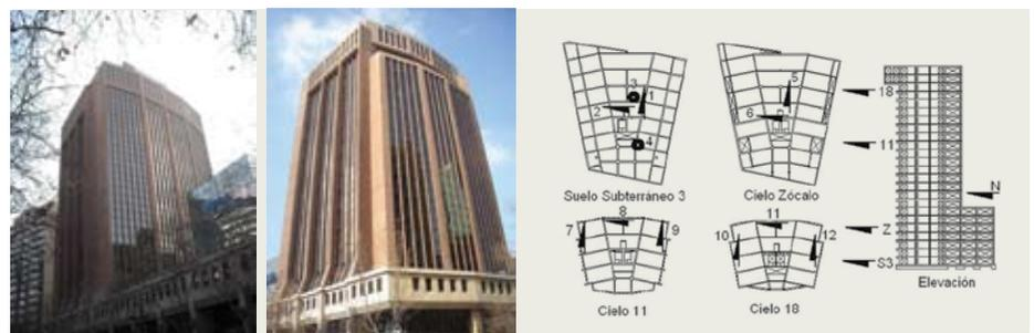
Adicionalmente es posible evaluar en forma directa las amplitudes de vibraciones en términos de velocidad, aceleración, desplazamiento, deformaciones unitarias y otras.
