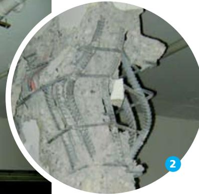
dejar la estructura como era originalmente, es decir, devolverle su condición presísmica. Si tuvo daños estructurales, mayores a los esperados según el criterio de diseño sísmico que establece la norma NCh433of.96, una reparación no basta, debiendo ser reforzada, cuando a una estructura dañada o sin daño se le modifican sus características de modo de alcanzar un nivel de seguridad predeterminado mayor que el original.
