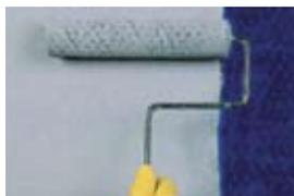
**6. Repetir la aplicación de capas de resina, lámina de fibra y resina, según se necesite.**
