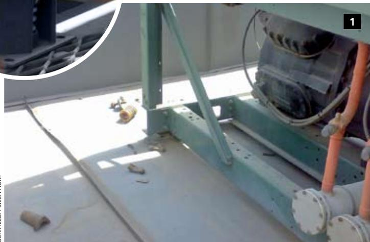
1. Chiller caído tras el terremoto debido a un anclaje insuficiente.
