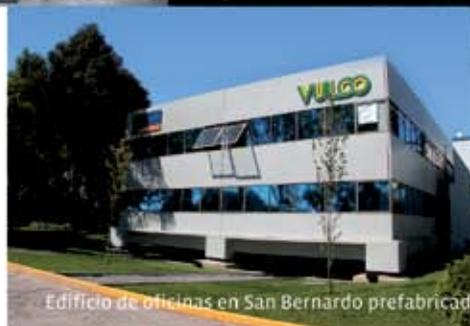
Edificio de oficinas en San Bernardo prefabricado en hormigón armado sobre aisladores sísmicos.
