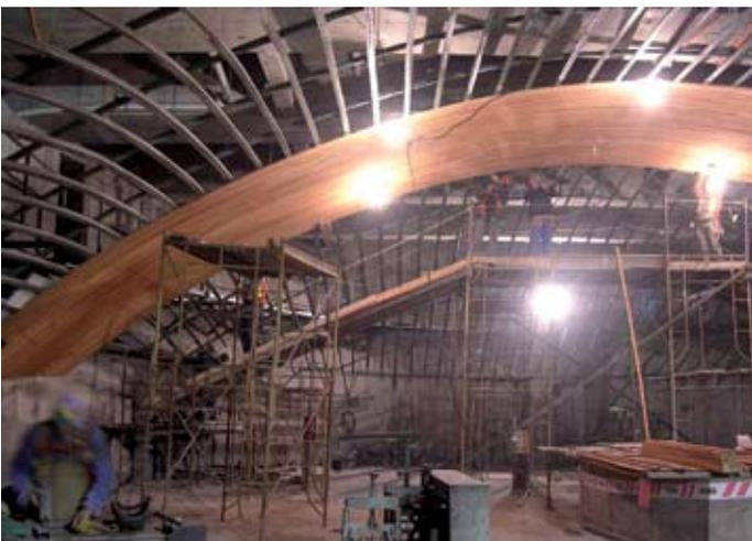
**Construcción de la cúpula de madera que cubre el cielo del segundo año de guarda.**
