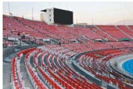
**TRABAJO TERMINADO.** El revestimiento se aplicó sobre los soportes de los asientos, evitando que la humedad penetre por las perforaciones.
