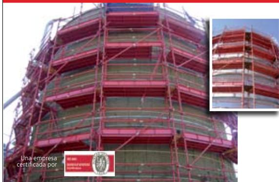
Innovación es colocar un producto o servicio inexistente hasta el momento a disposición de los clientes. Form Scaff y su sistema de andamios Kwik Stage entrega andamios para aplicaciones circulares con continuidad total en el perímetro con flexibilidad de niveles y plataformas. Barandas de seguridad en varios niveles y rodapié exterior e interior complementan dando seguridad.
