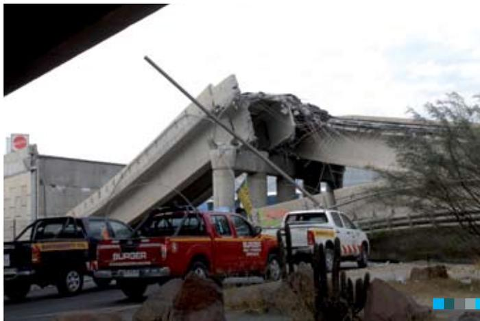
En general los prefabricados en puentes se utilizan como vigas simplemente apoyadas entre estribos y cepas. Con el terremoto, algunas de esas vigas perdieron el apoyo y se desplazaron fuera de su eje o cayeron, como muestra la fotografía.
