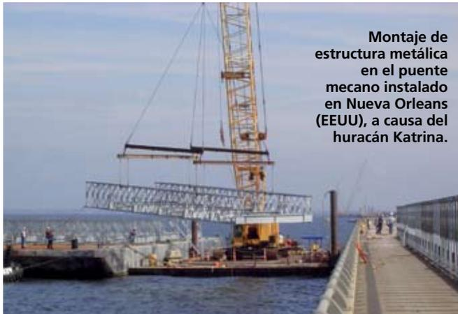
Montaje de estructura metálica en el puente mecano instalado en Nueva Orleans (EEUU), a causa del huracán Katrina.
