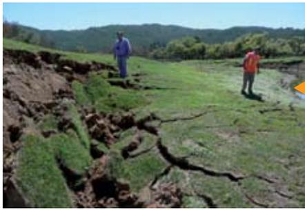
Desplazamientos laterales del suelo en las cercanías del embalse Tutuvén. También hubo deformaciones por licuefacción aguas arriba del reservorio, pero éstas no representan un riesgo para el embalse ni para el dique de tierra, construido en la década del 40.
