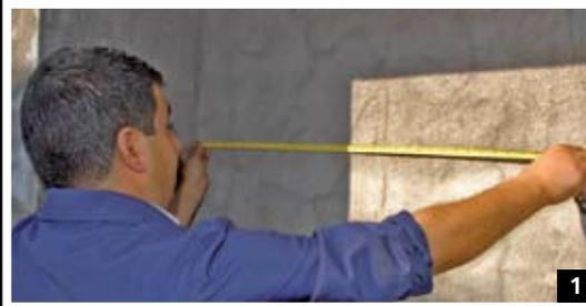
1. Medir que el ancho del gabinete donde se instalará el calefón, cumpla con la norma y permita una libre manipulación y una adecuada ventilación de éste.
