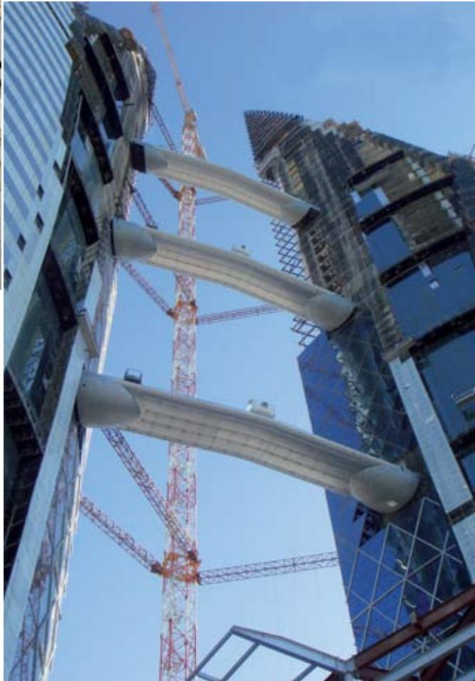
Para instalar los puentes y las turbinas en altura, una grúa de 270 m fue instalada entre las torres durante las faenas.
