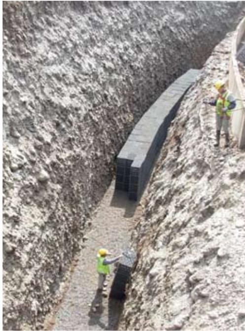
**Instalación del sistema cubo dren, que reemplaza al tradicional drenaje construido en obra con bolones.**
