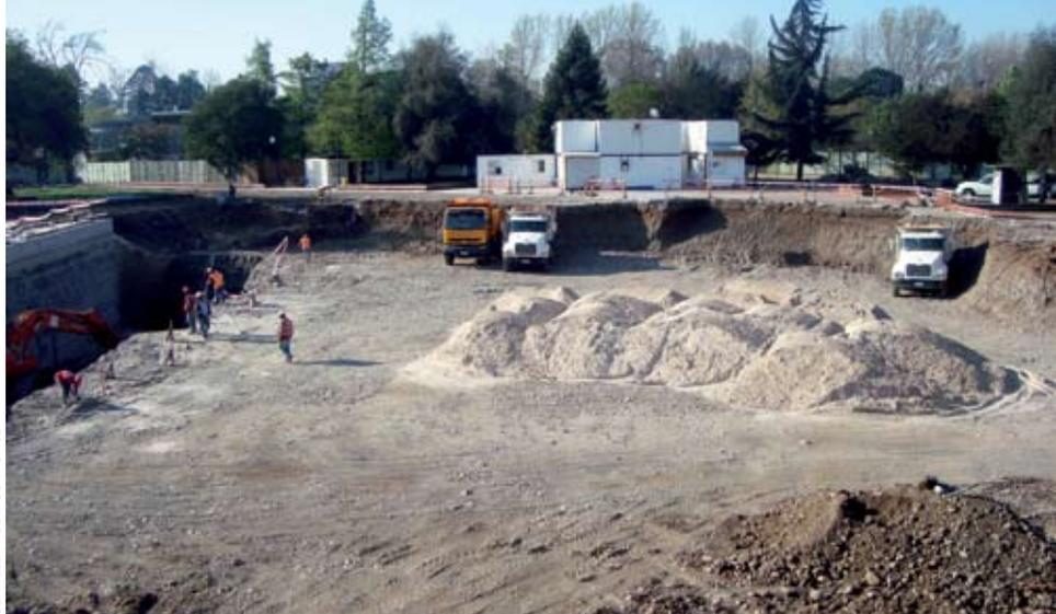
La construcción de una explanada a una cota de -2,5 m respecto del resto de la plaza requirió una excavación de aproximadamente 10 mil m<sup>3</sup> de tierra.
