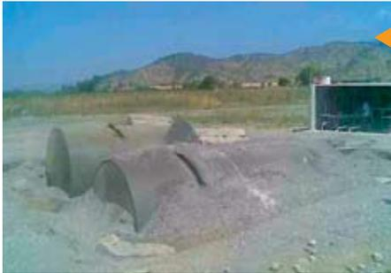
Abajo: Numerosos silos y tanques industriales sufrieron daños debido a la fuerte sollicitación sísmica con alto contenido de periodos largos. Existen varios casos reportados donde la falla fue causada por licuefacción del terreno de fundación.
