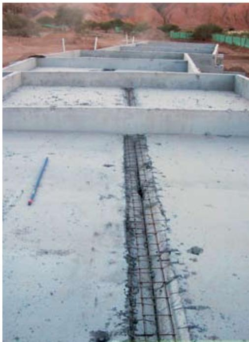
◀ Por la restricción en el tamaño de los paneles, algunas losas de la cubierta debieron unirse a través de costuras realizadas poniendo hormigón sobre la enfierradura dejada en espera.
