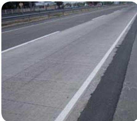
que se recibe sólo un set de ruedas simultáneamente, lo que hace posible disminuir el espesor de las losas entre 4 y 10 cm, generando así un ahorro sustancial en materiales y, en consecuencia, disminuyendo la inversión requerida.
