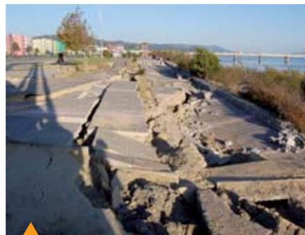
**Destrucción del pavimento producto de la licuefacción y deformación lateral del terreno en la ribera norte del río Bío Bío.**
