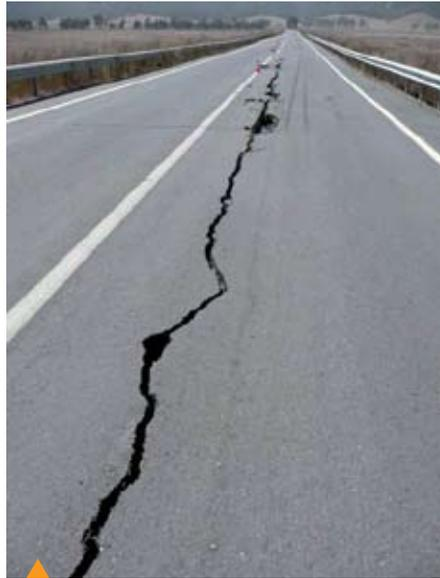
En puentes, la observación más común fue la falla en los rellenos de accesos a causa de los movimientos sísmicos. Hubo numerosos asentamientos de rellenos de acceso por las vibraciones sísmicas. En la foto se aprecia el impacto de la licuefacción y el desplazamiento lateral en el tramo norte del Puente de Mataquito.
