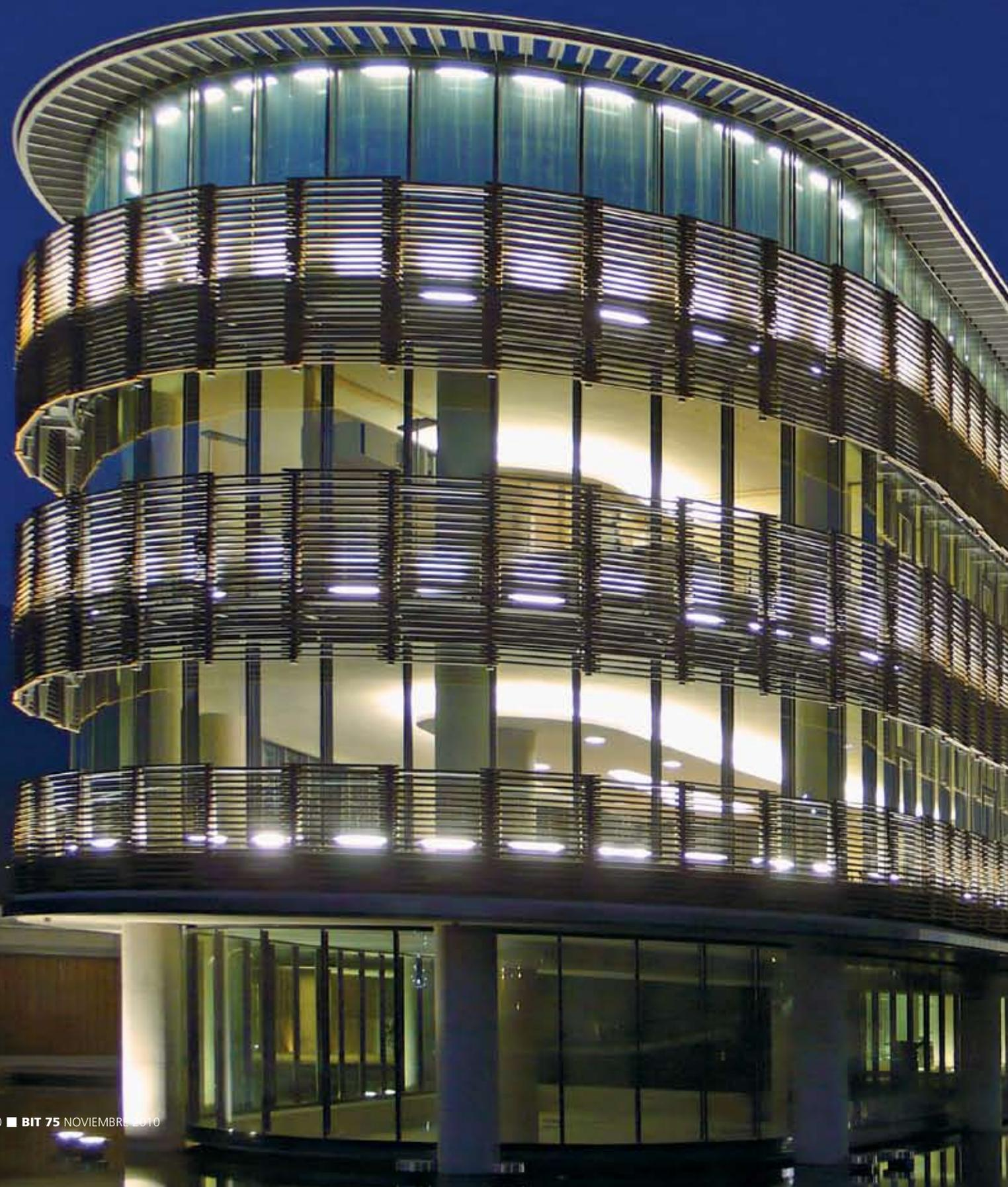
■ Un recinto ondulante de cuatro pisos que encierra múltiples desafíos técnicos y constructivos, es la nueva casa matriz del grupo de empresas Transoceánica. Destacan en su diseño y construcción, una fachada que protege de la radiación solar, totalmente prefabricada, y el uso de tecnologías eficientes en impermeabilización, iluminación y clima.
