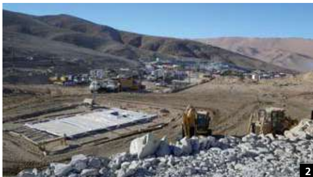
PLAN C 1. Perforadora petrolera. 2. Construcción de la plataforma de hormigón donde se emplazó la sonda.
