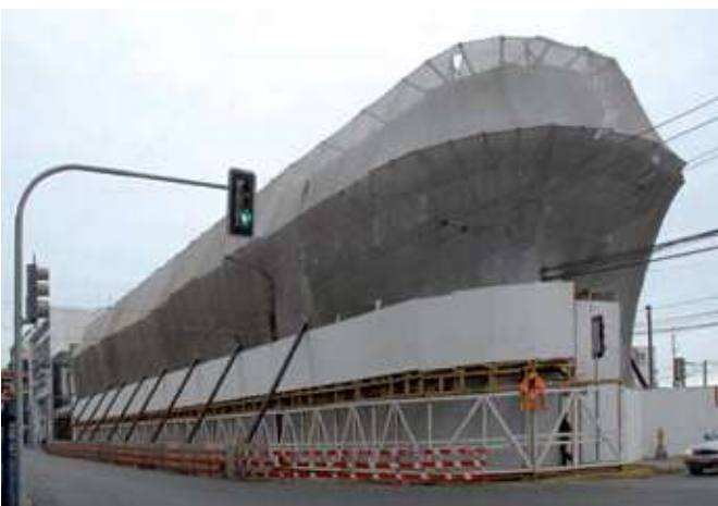
Inicio de las obras de reparación del edificio Luis Cousiño.
