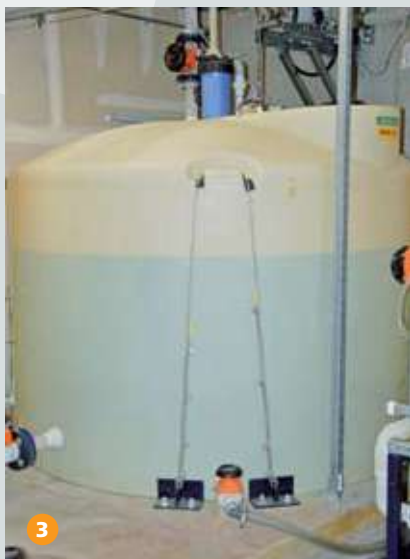
1. Cielo falso con redes de servicios anclados. 2. Red de tuberías con sus fijaciones. 3. Estanque con sus anclajes y restrictores.
