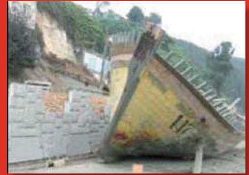
MURO EN MONTAJE AL MOMENTO DEL TSUNAMI
