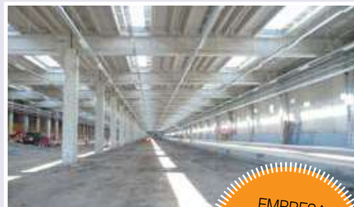
Talleres y Cocheras San Eugenio METRO Línea 5
