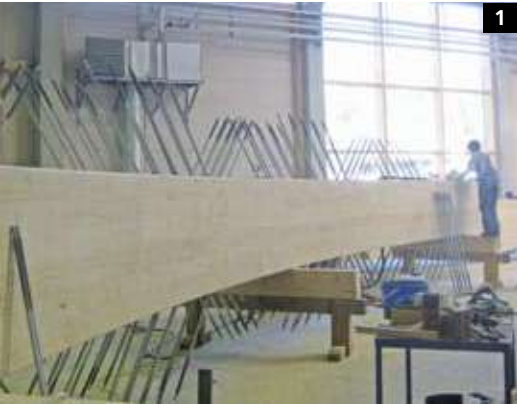
1. Una serie de barras de acero de 48 mm de diámetro son las que conectan cada una de las vigas de madera.
