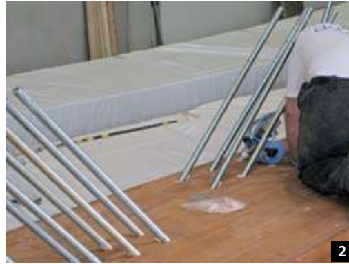
2. Para no tener problemas con el alto contenido de ácido de la madera, lo que se hizo fue realizar estas conexiones de acero con insertos de poliuretano.
