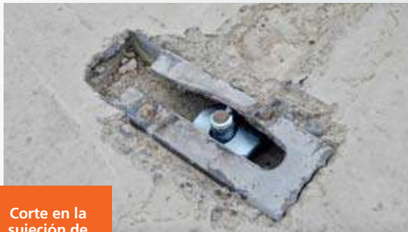
Falla de fijación de paneles verticales. El inserto embebido en el panel no resistió el movimiento del sismo.
