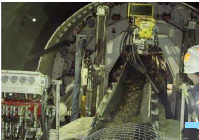
RETIRO DE MARINA Las láminas de roca o "chips" generados por los discos de corte, son capturados por tolvas, y vaciados en un buzón que los traspasa a la cinta transportadora de la TBM.
