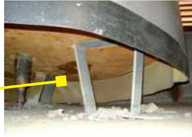
Estanque de agua caliente desplazado de su base a causa de un anclaje insuficiente.
