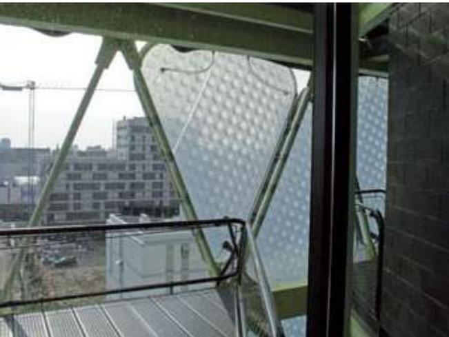
La arquitectura preformativa aplicada en el Media-TIC genera una nube de nitrógeno alrededor de la fachada. Ocupa la densidad del aire de sus partículas para crear un filtro solar.
