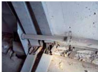
Canalización eléctrica dañada, dejando los cables al descubierto.
