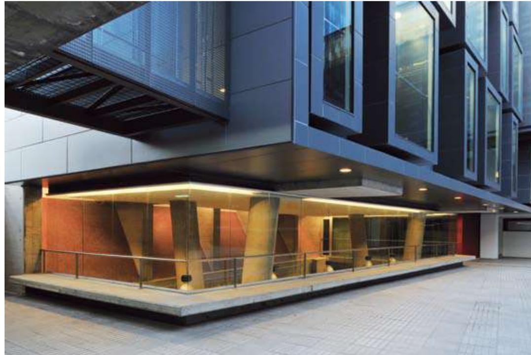
El segundo. El hormigón utilizado en los pilares. "Utilizamos un hormigón súper fluido (autocompactante) de la empresa Ready Mix, que es muy plastificante y maleable, condición que evita vibrarlo. El resultado final parece como si se tratara de hormigón visto, de terminación", comenta Álvaro Ovalle. Finalmente, y sobre los pilares se ejecutó una gran losa postensada, sobre la cual parte hacia arriba el edificio.
