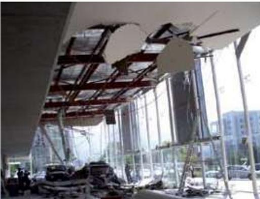
Los cielos falsos conectados a estructuras metálicas presentaron más daño que aquellos sujetos a losas de hormigón armado, siendo las áreas más afectadas las zonas donde se unen elementos flexibles y rígidos, respectivamente.
