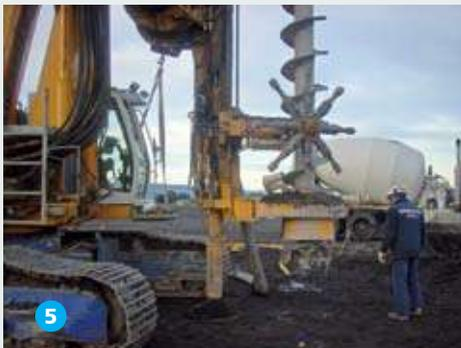
1. Ejecución pilote CFA de 18 m de longitud.
