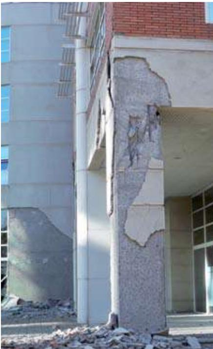
En ciertos muros delgados se observaron fallas frágiles por exceso de compresión.
