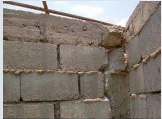
En Arica, Iquique y Antofagasta, es vital revisar la construcción en albañilería de bloque. En el detalle se muestra un muro medianero dañado en el terremoto de Tocopilla de 2007.
