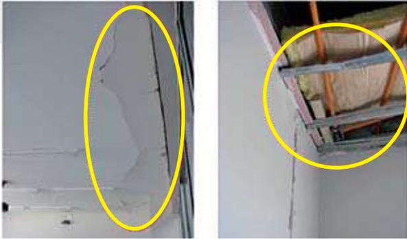
Deterioro por fuerzas de compresión de los muros laterales, debido al distanciamiento inadecuado de los cuelgues y a que el cielo se encontraba fijo al perímetro.
