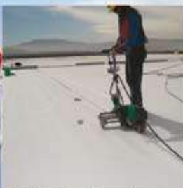
Instalación de membrana TPO de Firestone en techo
