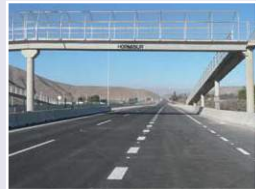
10 PASARELAS EN RUTA 5 ENTRE VALLENAR Y CALDERA
