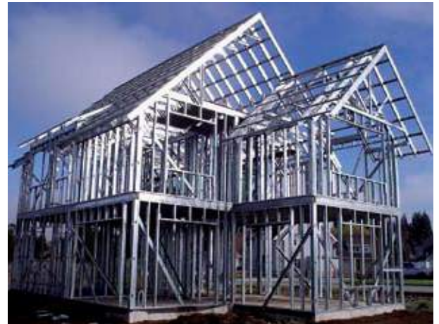
Las casas están construidas en estructura metálica de acero galvanizado, con propiedades antisísmicas.
