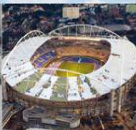
Revestimiento con membrana TPO Firestone
