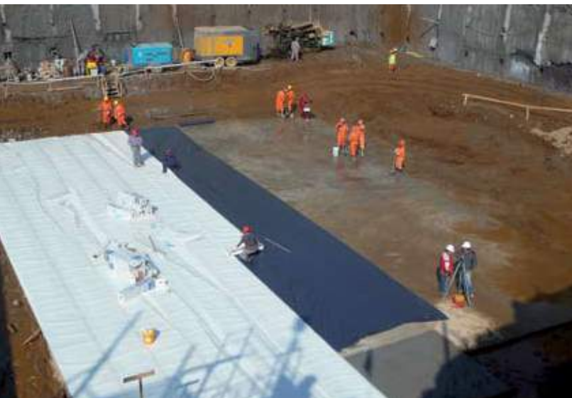
Marzo 2011, Obra Multicentro Talca, Constructora Tecsa Losa 3º Subterráneo.
