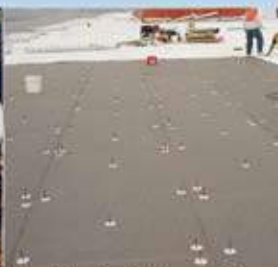
Instalación de Placas ISO 95+ de Firestone
