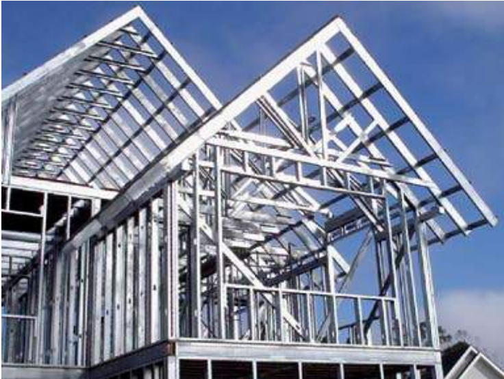
Las casas están construidas en estructura metálica de acero galvanizado, con propiedades antisísmicas.
