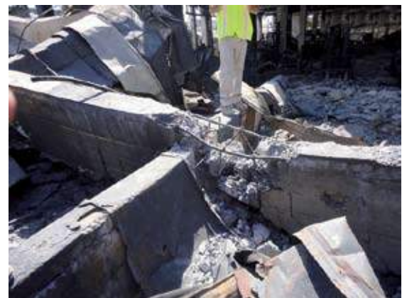
Viga colapsada por el incendio.
