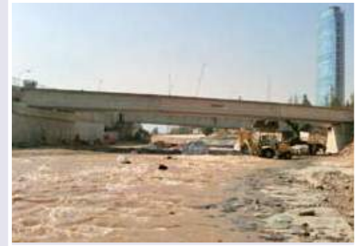
VIGAS PUENTE COSTANERA CENTER
