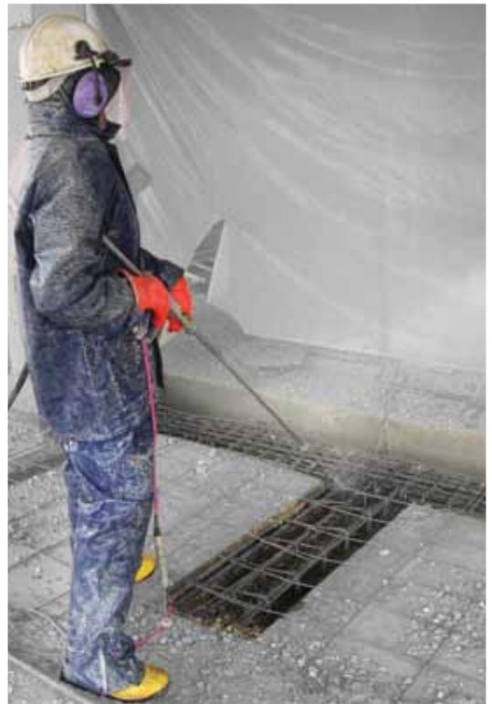
**La hidrodemolición manual se utiliza para estructuras menores donde máquinas de mayor tamaño no pueden acceder.**
