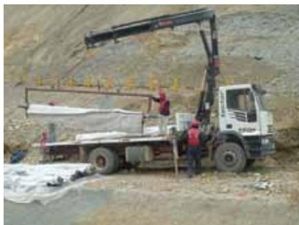
permitió la construcción del canal de rehabilitación, colocando las rocas en la forma y posición requerida por el diseño hidráulico, generando estructuras estables, resistentes a la erosión y protegiendo las riberas del río rehabilitado”, sintetiza Robledo.
