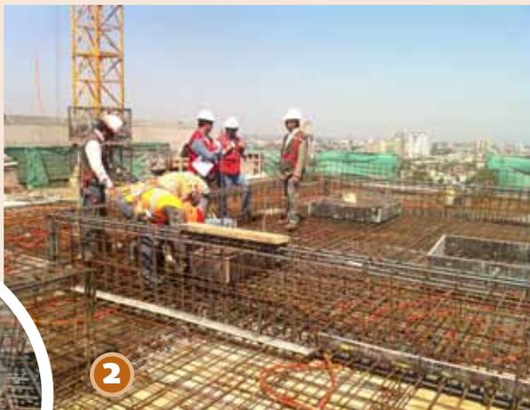
La instalación del sistema AMS comienza antes de hormigonar la losa de la cubierta. Las dos masas se apoyan sobre la losa, la cual debió ser reforzada con barras de acero adicionales y vigas invertidas que permiten sostener el peso de los AMS.
