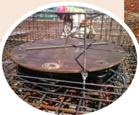
Desde la misma losa de cubierta se ubican las enfierraduras de los capiteles de hormigón armado que posteriormente recibirán a los aisladores. Estos capiteles contienen los insertos metálicos necesarios para apernar los aisladores.
