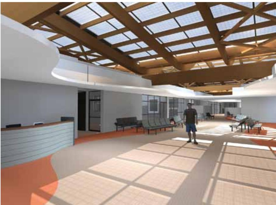
Utilizar la luz solar era uno de los objetivos de la techumbre propuesta. Para ello se utilizaron vigas de madera laminada, provenientes del continente y sobre ellas una cubierta de cristal.
