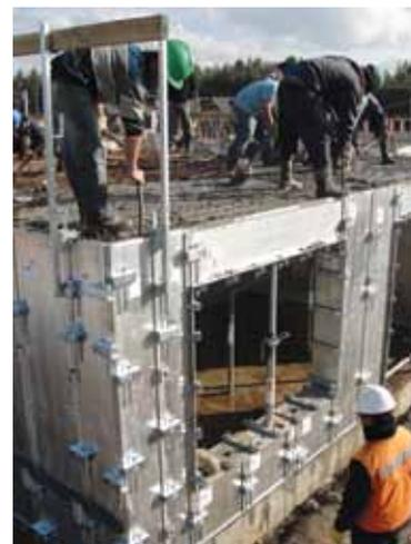
UNO de la empresa PERI, que se aplica a proyecto de gran cantidad de unidades iguales, tanto en planta como en alzado. Un dato relevante para la productividad. Los paneles se ensamblan a partir de perfiles individuales a medida de cada proyecto. Los de muros se ajustan a la solera mediante perfiles de sellado EPDM para compensar irregularidades del suelo en el que se apoyan. "Se reduce el plazo de las distintas etapas del proceso del encofrado, ahorro en mano de obra al ser ma-
