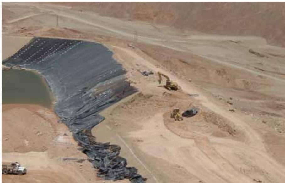
Para la instalación de las láminas se utilizó un aditamento que se colocó en el balde de una excavadora o de un camión pluma, con él se levantó el rollo del material impermeabilizante.
