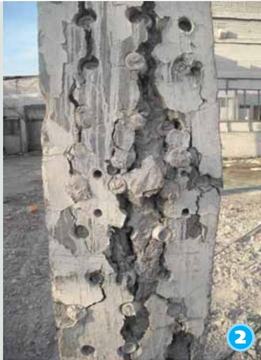
**1.** Primero se realizan las perforaciones en las que se introduce el material expansor para debilitar la roca o el hormigón.
