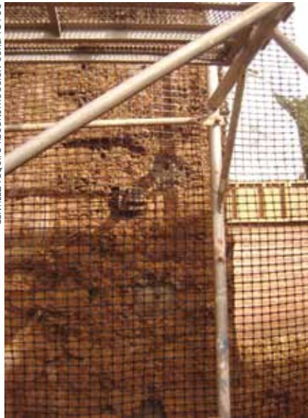
**El muro de adobe se conserva en el primer piso. Anclajes de acero en el sentido de la separación y escalerilla perpendicular que evita la rotación, son confinadas al adobe y al tabique del segundo piso mediante la disposición de geomalla.**
