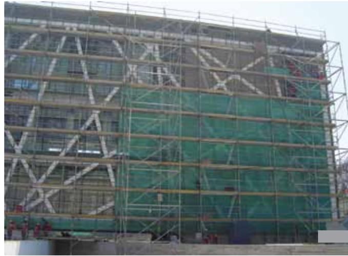
**20 de las 880 toneladas de acero utilizadas en la construcción del museo correspondieron a alzaprimas, que permitieron el montaje de la 'Barra'. Para retirarlas, se utilizó un sistema hidráulico que elevó la estructura entre 2 a 5 mm, lo que permitió sacar las laines y posteriormente las alzaprimas.**
