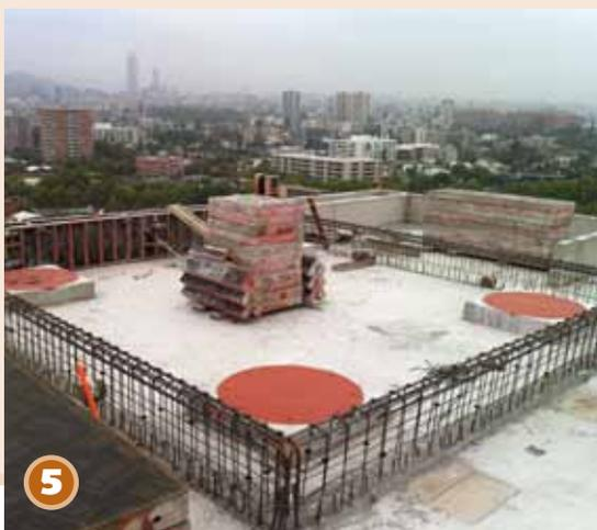
Luego de verificar la altura y separaciones de los capiteles con las vigas, se procede a hormigonar dichas vigas. Esta estructura además de contribuir a soportar el peso de los AMS, delimita el espacio que la masa ocupará al desplazarse durante un evento sísmico.
