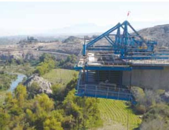
El carro de avance es una estructura metálica compuesta por cerchas soportadas por un marco principal montados sobre rieles que permiten su traslado. En él se monta el encofrado de la dovela. El avance de cada carro fue de 3,5 m (longitud de la dovela).
