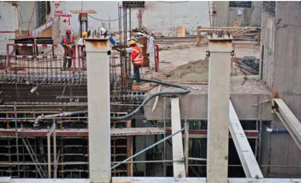
Se tomaron medidas especiales para prevenir las caídas de los obreros. Como el trabajo se realiza en alturas de hasta 15 metros se colocaron mallas para proteger a los trabajadores en caso de un accidente o caída de algún material hacia un piso inferior.
