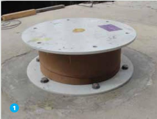
1. El aislador aplicado en el edificio del horno de Cristalerías de Chile, es de tipo elastomérico, de goma de caucho natural con y sin corazón de plomo. Existen tres tipos de 70, 80 y 85 cm de diámetro los que son anclados por medio de pernos tipo ASTM A325.
