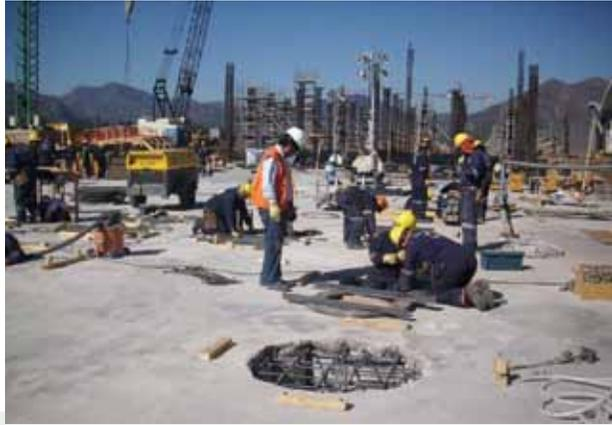
**Paso siguiente, se hormigona la losa de fundación, dejando cavidades de aproximadamente 100 cm de diámetro, dependiendo de los dispositivos a instalar en cada posición. Posteriormente se instalarán los anclajes para los aisladores.**
