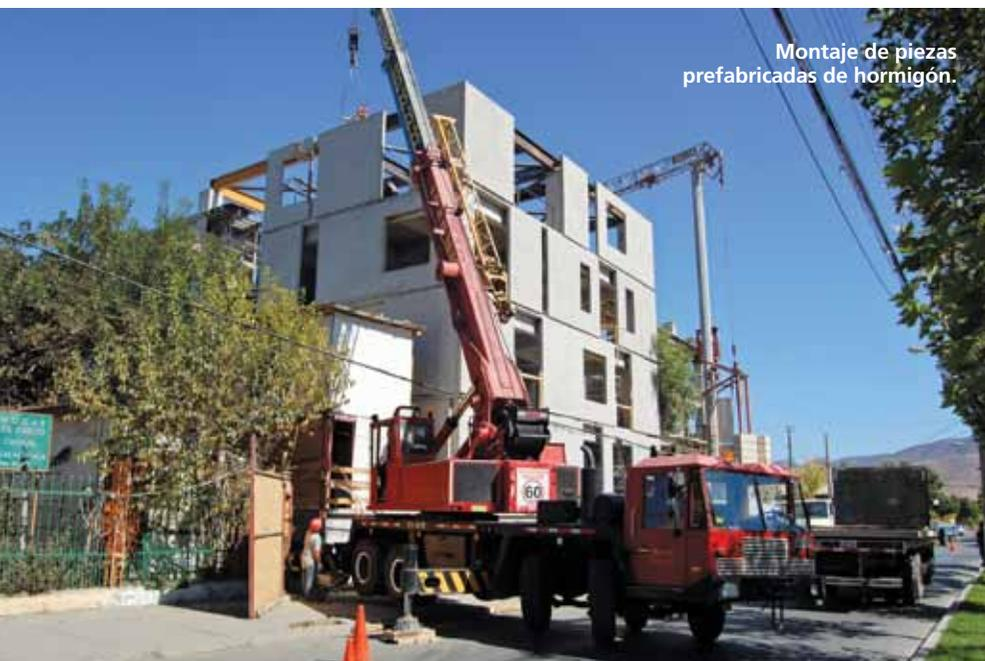
Montaje de piezas prefabricadas de hormigón.
