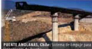
PUENTE AMOLANAS, Chile: Sistema de Empuje para lanzamiento de Puente.
