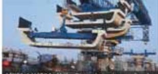
LÍNEA 4 METRO, Chile: Pórtico Lanzador para Dovelas Prefabricadas y postensado transversal y longitudinal.
