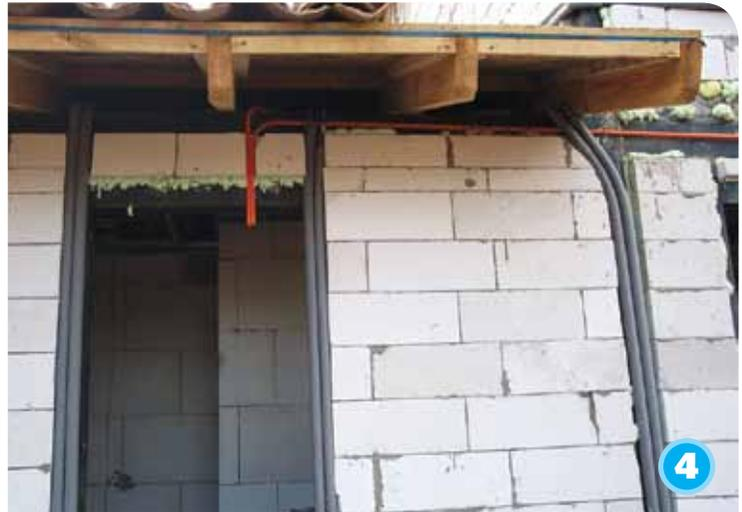
Utilización de espuma de poliuretano en las juntas de pega de perfiles con bloques de hormigón celular.
