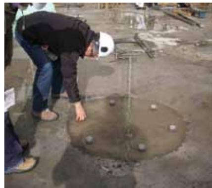
**Una vez culminado el grouting o relleno estructural de hormigón, del anclaje se procede a instalar el dispositivo de aislamiento.**
