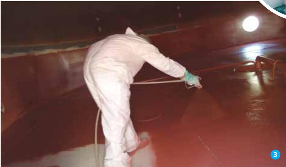
material y del proyecto. "Para la corrosión atmosférica, por ejemplo, se debe implementar un sistema con revestimientos y, para la corrosión electroquímica, se debe utilizar protección catódica. En casos de un fluido, pueden ser los inhibidores, complementados con otras soluciones", indica Gutiérrez.
