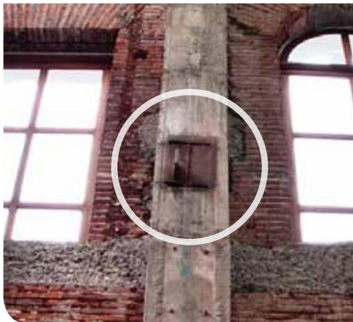
El muro es de albañilería simple, pero en el proceso de la historia, se le anexaron cadenas de hormigón y éstas "se apuntalaron con unos diagonales, a dados de hormigón de 2 x 2 m. Con eso se mantenía la fachada en su posición", comenta el arquitecto. Estas barras fueron removidas y reutilizadas en el proceso constructivo.
