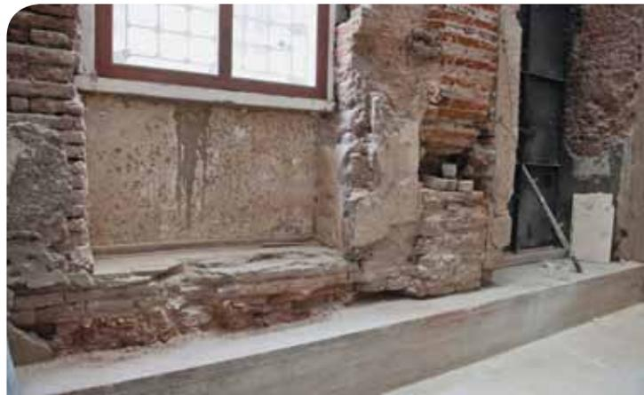
El muro poseía fundaciones con bolones que fueron confinados con una viga de hormigón, para que la base del muro mantenga sus condiciones y no se disgregue. "Con ello, se le dio una terminación de lo que sería la transición", señalan los arquitectos. La viga fue confeccionada con tableado, igual que los contrafuertes antiguos. Había que seguir la misma la línea estética.
