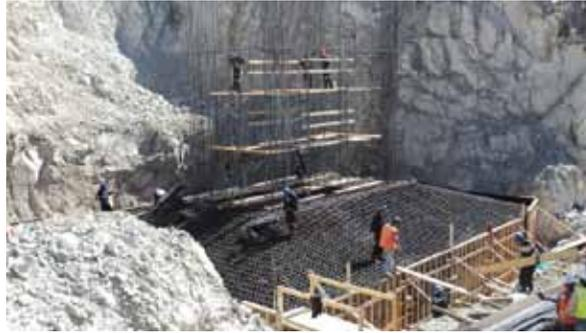
sus dimensiones, fueron ejecutadas in situ en tres fases. Esta sección resultó clave para la construcción del puente. Ante la imposibilidad de acceder a la cuenca del río, para solucionar el problema de la logística, se instaló una grúa torre en el eje de cada pila, para aprovechar su misma fundación. Entre las dos, se cubrió el área completa del tablero.
