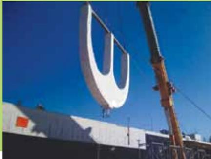
La construcción de la Menoráh, diseñada por el arquitecto Gabriel Bendersky significó todo un desafío constructivo. Debió ser fabricada in situ, de forma horizontal e instalada con grúas de alta capacidad.
