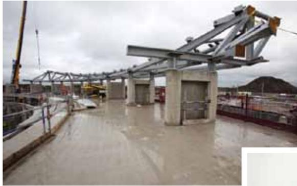
La estructura de acero que soporta la cubierta y las gradas del segundo nivel, fue montada sobre 48 columnas de hormigón que rodean la pista central. En la parte superior se instalaron 2.500 asientos.
