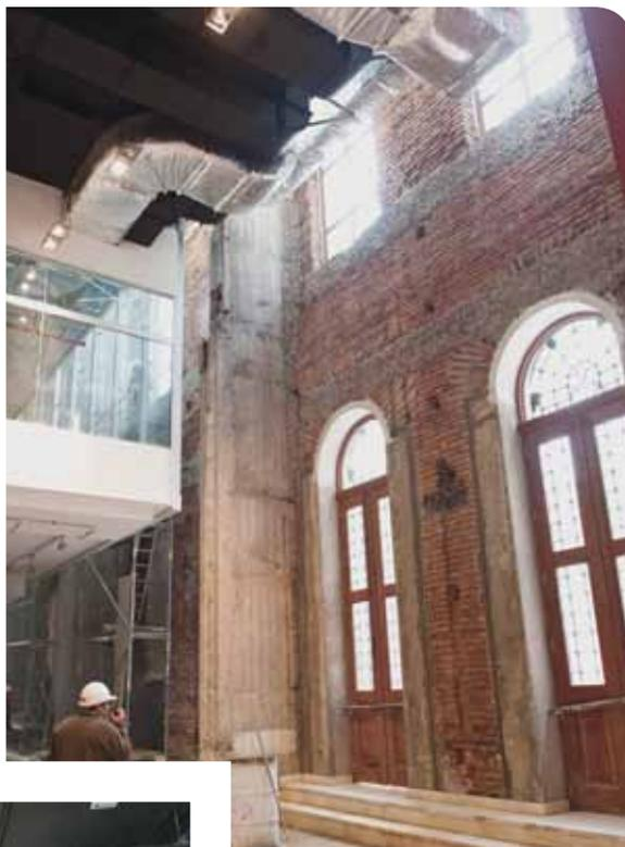
Para dejar la cubierta libre de equipos de clima y extracción se subió la altura del techo del patio de comidas (se trabajó en un rango de 5 m de piso a cielo) y todos los ductos quedaron contenidos dentro del patio de comidas. Estos fueron pintados de color negro, para que cuando se ilumine el espacio se pierda la noción del fondo y no se noten los equipos. La visibilidad queda a la altura de las luces.
