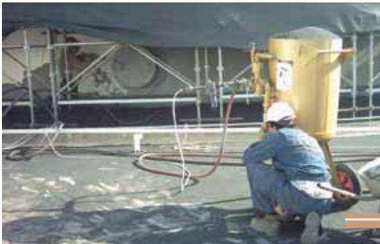
Un equipo de limpieza abrasiva. Existen diversos tipos de abrasivos. El más utilizado es el arenado y últimamente la escoria de cobre. El tipo y las dimensiones de cada elemento proyectado, dependerá del perfil de rugosidad que se quiera lograr en la superficie a tratar.
