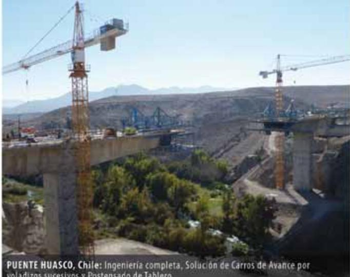
PUENTE HUASCO, Chile: Ingeniería completa, Solución de Carros de Avance por voladizos sucesivos y Postensado de Tablero.
