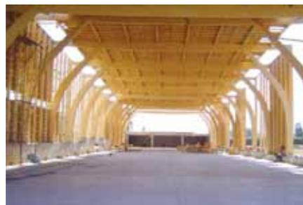
forma, se izan mediante grúas de 12 a 15 t (según el proyecto puede variar). A continuación se colocan las costaneras apoyadas contra los tijerales, en herrajes precolocados antes del izaje de los marcos.
