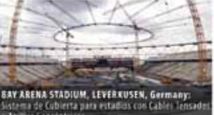
BAY ARENA STADIUM, LEVERKUSEN, Germany: Sistema de Cobertura para estadios con Cables Tensados e Anillos Concéntricos.
