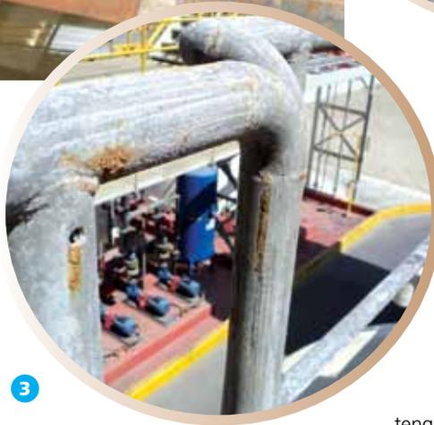
1. Acero carbono expuesto a la humedad y con avanzado estado de oxidación.
