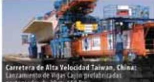
Carretera de Alta Velocidad Taiwan, China: Lanzamiento de Vigas Capa prefabricadas postensadas de 30 m, 650 Ton.
