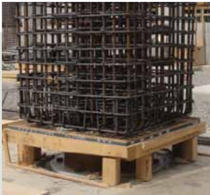
Sobre el aislador elastomérico se monta la enfierradura del capitel, del cual nacen los pilares.
