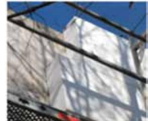
un espesor de 200 mm en una densidad de 20 kg/m<sup>3</sup>, ofrece una aislación térmica de alto desempeño, la cual además protege la estructura.
