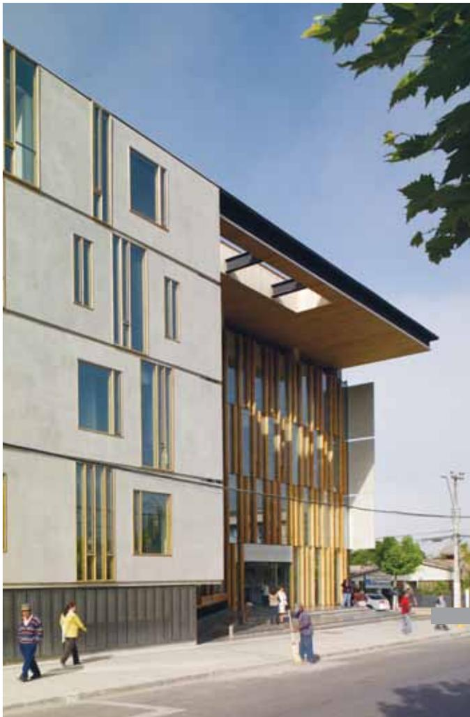
La placa de hormigón prefabricado en precio, compite con la albañilería confinada. Por ello, se consideró apropiado como elemento constructivo para el Edificio Consistorial, así como lo fue años atrás para la bodega de Lampa.
