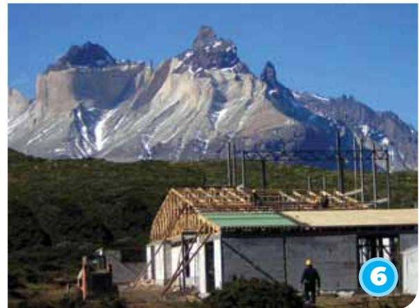
Levantamiento de muros de hormigón celular con aislación más barrera de vapor por el exterior.
