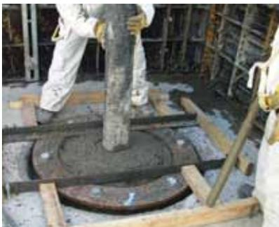
**Tras la nivelación de los anclajes se hormigonó, utilizando hormigón idéntico al de la losa de fundación, para conseguir uniformidad.**
