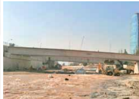
VIGAS PUENTE COSTANERA CENTER
