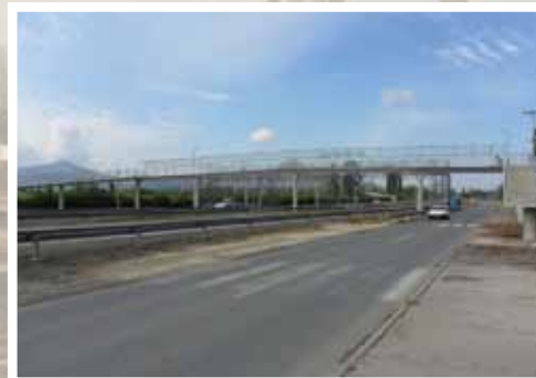
4 PASARELAS EN AUTOPISTA LOS LIBERTADORES
