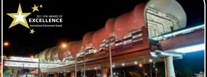
Estación de metro Laguna Sur
