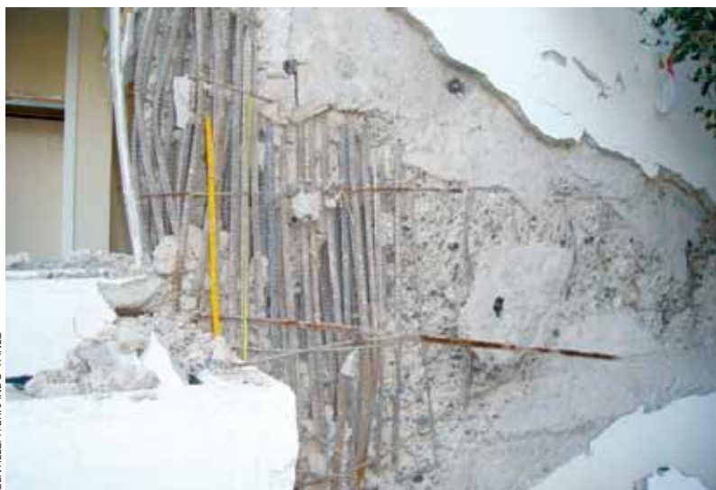
Daños ocasionados por el terremoto del 27 de febrero de 2010.
