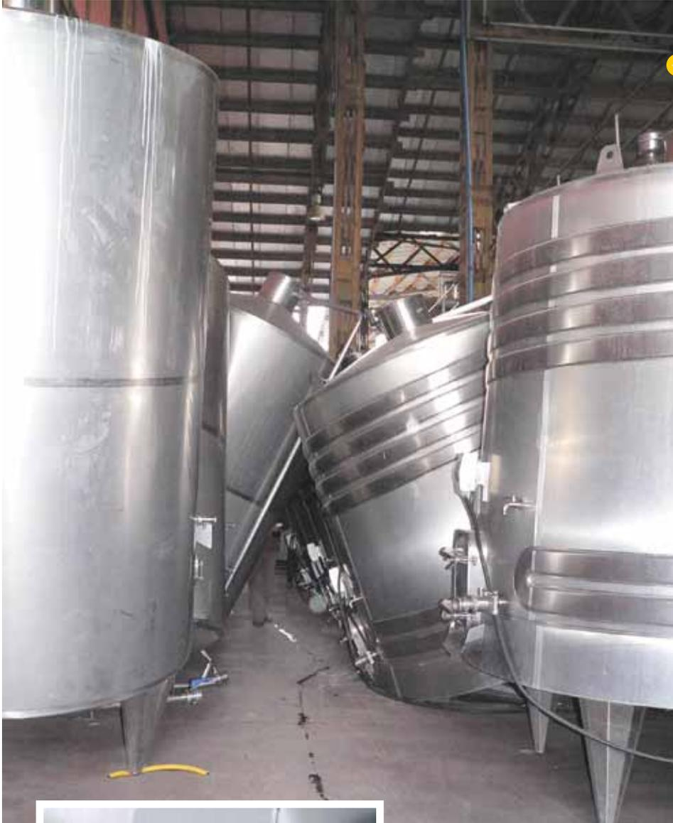
En el caso de las bodegas de vino, los estanques apoyados en patas fueron uno de los sistemas de almacenamiento más afectados. Esto se debió, en parte, a la falta de un procedimiento de diseño estandarizado que indujo a una gran variedad de estructuraciones que, en general, presentaron comportamientos deficientes. Dentro de las principales fallas estuvieron el pandeo de patas, volcamiento y deslizamiento, incrustación de patas, y colapso del manto/techo por vaciado rápido.
