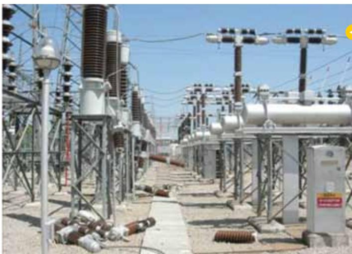
En el caso de la generación, transmisión y distribución eléctrica, los principales problemas se presentaron en la infraestructura de distribución que tardó hasta semanas en recuperarse. El daño masivo estuvo en las líneas de conexión entre el tendido de baja tensión y los usuarios. En los transformadores y postes, fueron mínimos. En la imagen, la subestación de la línea de 154 kV, Hualpén-Bocamina, en Concepción.
