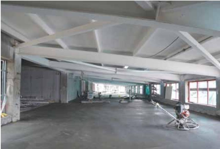
Se observa el piso mecánico con la cubierta que incorpora aislación térmica y la sobrelosa de piso con aislación acústica.
