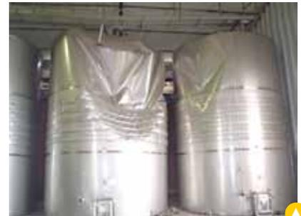
El deslizamiento de estanques apoyados en patas (y en ocasiones su posterior volcamiento), se debió a la fractura de los pernos de anclaje y/o a la ausencia de ellos entre las patas del estanque y la losa de hormigón.
