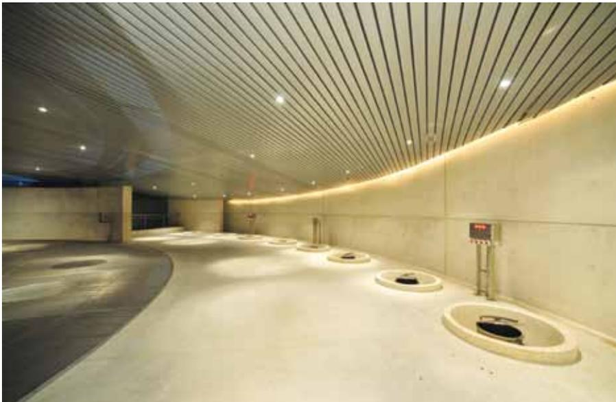
contacto con los hormigones, se atornillaba desde atrás por la contracara, de manera de asegurar una superficie de terminación final libre de marcas de tornillos y fijaciones. El uso de esta doble capa permitía que los muros no tuvieran deformaciones y sus caras quedaran lisas y aplomadas, gracias a la rigidez de las dos placas sumadas.
