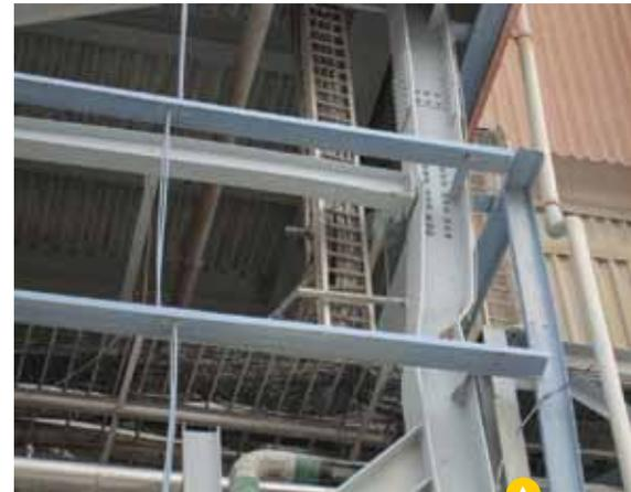
▶ Durante el sismo, hubo impactos entre estructuras en varias zonas, especialmente en las plantas de celulosa donde todo está conectado a través de puentes y cañerías. Las uniones deslizantes de 50 mm o similares no funcionaron.
