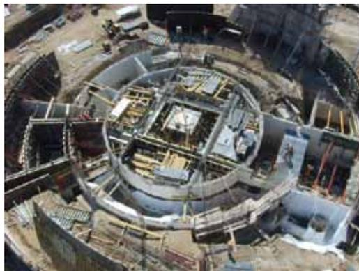
La forma curva de la bodega refuerza su carácter gravitacional, que permite descargar la uva hacia las cubas sin necesidad de utilizar bombas. Los muros de las velas alcanzan alturas de hasta 14 metros. Para lograr unidad en sus diagonales, se realizaron sucesivas tandas de moldaje hacia arriba.
