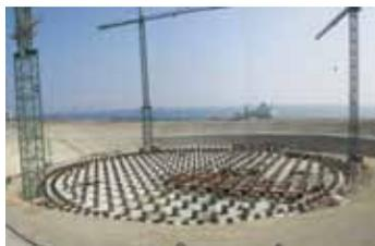
Sistema de aislamiento sísmico planta de gas GNL Mejillones
