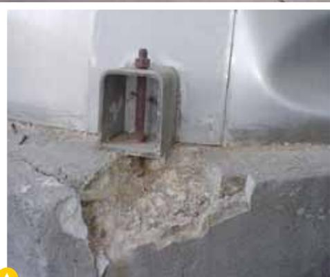
Las principales fallencias en los sistemas de anclaje, se explican por la corrosión de pernos, una longitud de anclaje insuficiente, mala calidad del hormigón y la presencia de placas base de bajo espesor.
