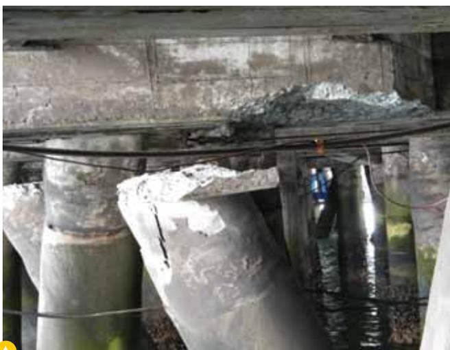
Debido a la fuerza del sismo, el muelle de Huachipato sufrió la falla por corte rasante de todos los pilotes inclinados, en la interface entre el pilote de acero y la losa de hormigón armado.
