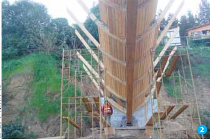
Una vez en el lugar, se procedió al armado. En la parte inferior, se observa la viga madre que resiste la flexión, mientras las deformaciones son controladas por el conjunto, formado por esta viga madre y dos vigas secundarias paralelas ubicadas a los costados.
