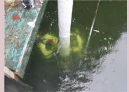
Todos los pilotes se reforzaron desde la zona inferior de las vigas hasta un mínimo de 60 cm bajo la zona tidal (tramo que se moja y se seca conforme sube y baja la marea, dos veces al día). La instalación de tela de fibra bajo agua fue ejecutada por buzos certificados.
