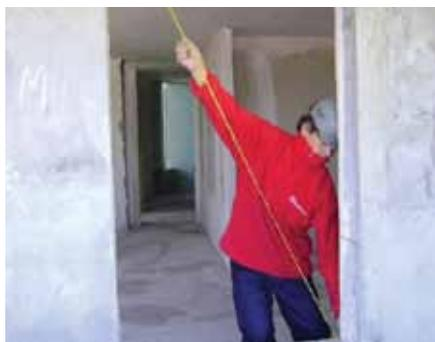
Para que la descripción de los vanos sea exacta, hay que realizar tres medidas en vertical (en los dos extremos del ancho del rasgo y en su centro) tres en horizontal (en los extremos inferior y superior, así como en su centro) y dos en diagonal, por si el vano estuviera descuadrado. Todas las mediciones deben estar en milímetros.
