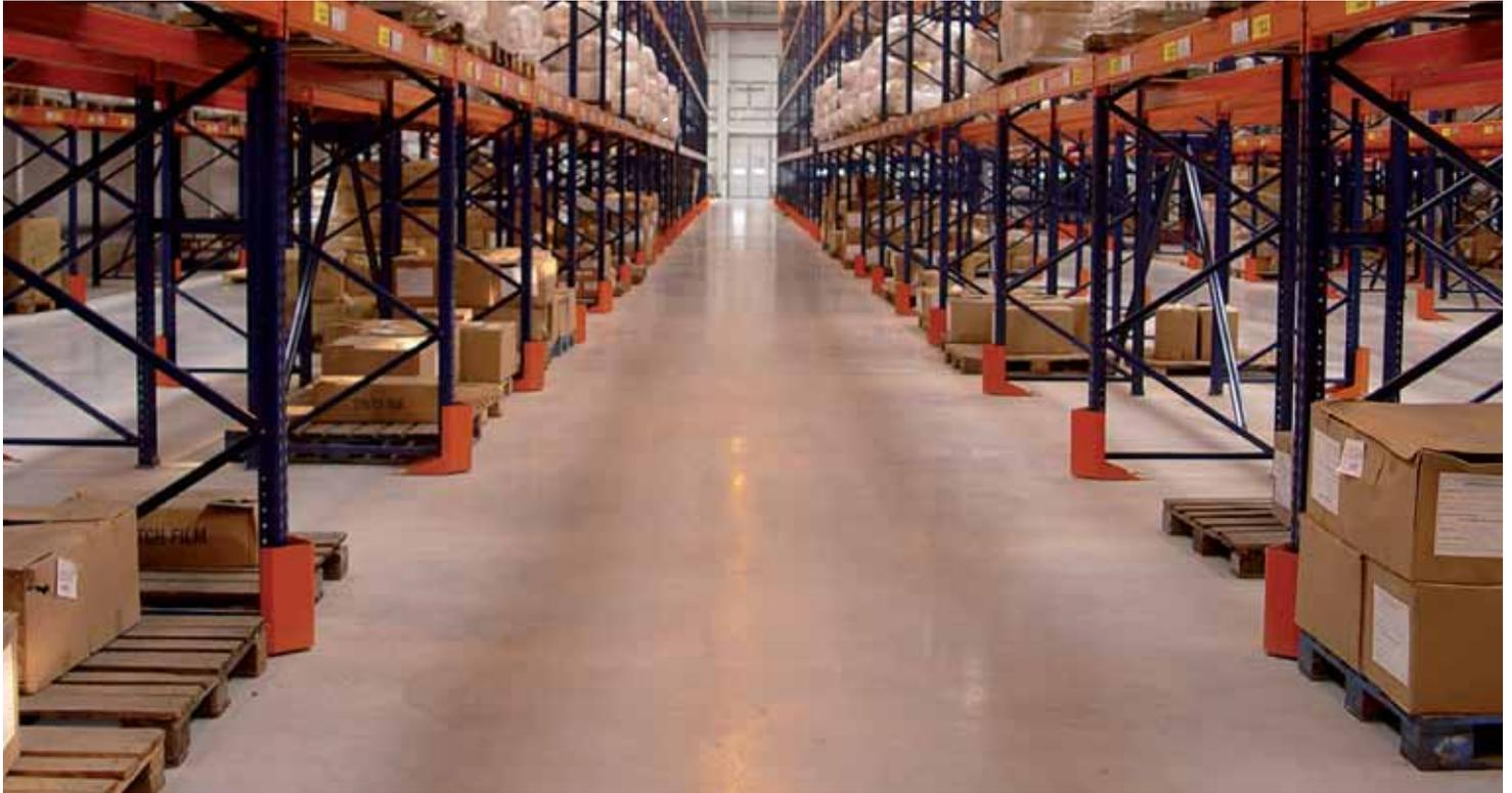
**Nuevo Continua**, el nuevo hormigón de retracción compensada de Melón que permite construir losas de grandes superficies, sin juntas ni cortes.
