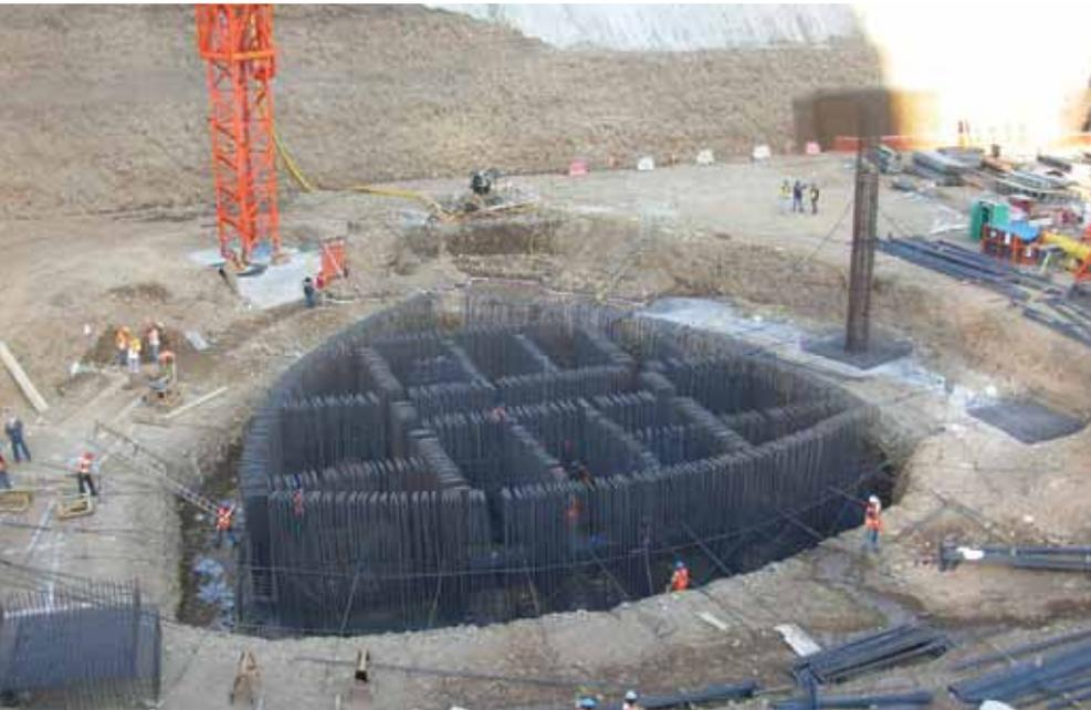
**La losa de fundación tiene 1,20 m (1 m en algunas partes), con vigas de fundación de 4 m previo al primer subterráneo. Desde allí se va constituyendo el núcleo.**
