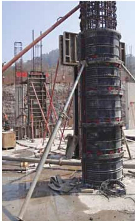
**Hasta el piso 15 de cada edificio las columnas tienen una dimensión de 100 cm con un hormigón H60.**
