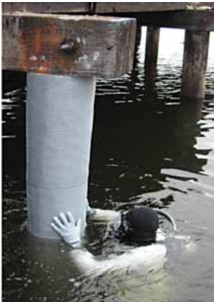
Se realizó un encamisado precurado de FRP que se rellenó con grout de curado bajo agua. El grout llena el espacio anular entre el encamisado, como también cualquier oquedad en los pilotes donde ha sido removido el material defectuoso.
