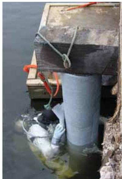
Se utilizó el sistema "wet lay up" o laminación húmeda, aplicada a los pilotes que requerían protección, pero que contaban con la mayoría de su superficie de sección transversal intacta. La fibra es saturada con un epóxico de curado bajo agua.
