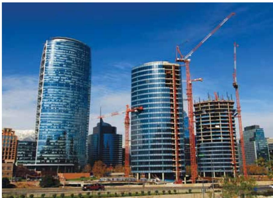
El proyecto de muro cortina, considera un sistema de burletes de goma en las uniones que facilita su instalación sin necesidad de silicona estructural. Eso acelera su montaje.
