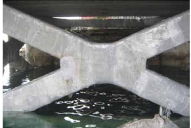
Terminada la reparación del hormigón, se diseñó el refuerzo con fibra para incrementar la capacidad a flexión y al corte en las vigas diagonales.
