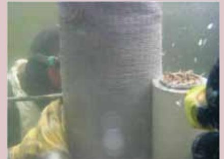
Estos sistemas pueden ser diseñados para proporcionar esfuerzo de corte adicional, confinamiento y esfuerzo de flexión de pilotes existentes. Aun cuando el proyecto no requería refuerzo estructural, los encamisados proporcionaron incremento en la capacidad a esfuerzo axial. El sistema wet lay up, proporcionó incremento en la capacidad de corte y confinamiento.
