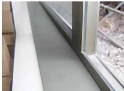
Debido a la diferencia de espesores de los muros, la ventana puede instalarse en tres lugares diferentes: enrasada a paño interior (alineada con el muro por su parte interior), a paños medios o como se aprecia en la imagen, enrasada a paños exteriores (alineada con el muro por su parte exterior).
