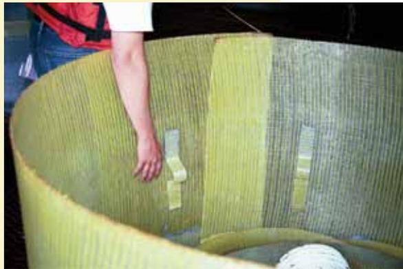
Las columnas, fueron encamisadas con fibra y saturadas con resina epóxica, para protegerlas en la sección de la marea (tidal zone). El color gris de la resina que cura bajo agua es similar al color del hormigón curado y mojado, de esta forma el proceso se mimetiza al punto de no ser percibido.
