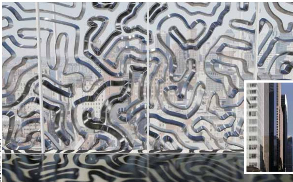
El sistema homeostático regula el clima interior del edificio al responder automáticamente a las condiciones ambientales. Además, dependiendo de la incidencia del sol puede cambiar sus “patrones de diseño” durante el día.
