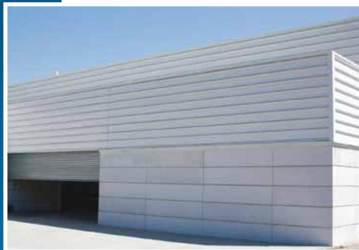
Aplicación del sistema en retail. Los paneles, tienen un proceso de montaje industrializado que disminuye los tiempos de la obra. En este caso, con los paneles dispuestos horizontalmente, la instalación completa de zócalos con paneles de Hormigón Celular se realizó en 23 días.
