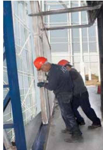
Para la instalación, el panel se levanta por medio de izaje mecánico y se dirige hacia la base de la estructura metálica en base a perfiles de acero. Luego, se debe mover el panel para encajarlo en la canal superior de la estructura. Una vez situado se procede a retirar las eslingas.
