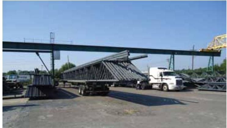
Para el transporte de carga, los especialistas recomiendan que el producto debe ir de forma invertida. Esto significa que la cuerda superior tiene que estar hacia abajo para estabilizar la carga.
