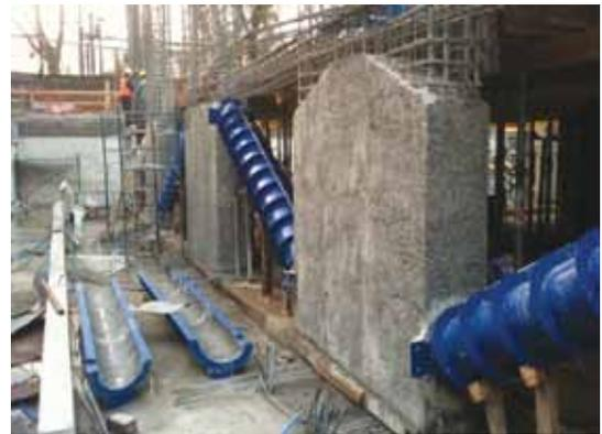
La fachada es un sistema mixto compuesto por una serie de muros y diagonales que reflejan cómo las fuerzas gravitacionales y cargas sísmicas deben buscar un camino distinto al habitual, evitando el volcamiento de la esquina.
