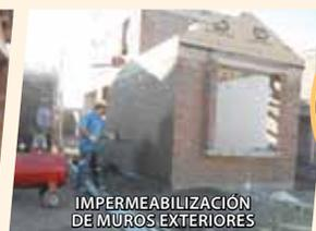
IMPERMEABILIZACIÓN DE MUROS EXTERIORES
