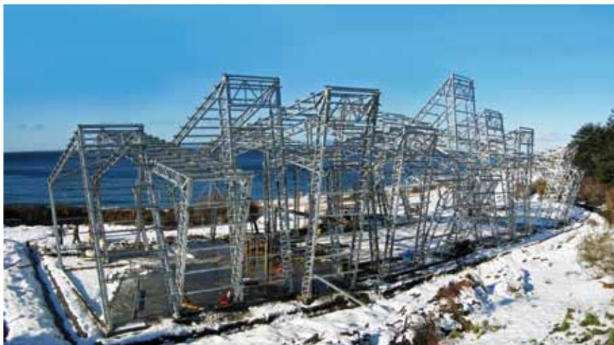
Se diseñaron y fabricaron cerchas reticulares para otorgarle los ángulos irregulares a la estructura.
