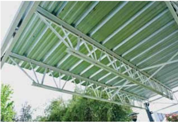
Muestra preparada para el lanzamiento del sistema, donde se observa la aplicación de vigas como estructura de techos, sobre la cual se instaló el panel de cubierta tipo PV4. Se observa la aplicación de los bridging diagonales, requeridos para dar estabilidad lateral a las vigas durante la etapa de montaje.
