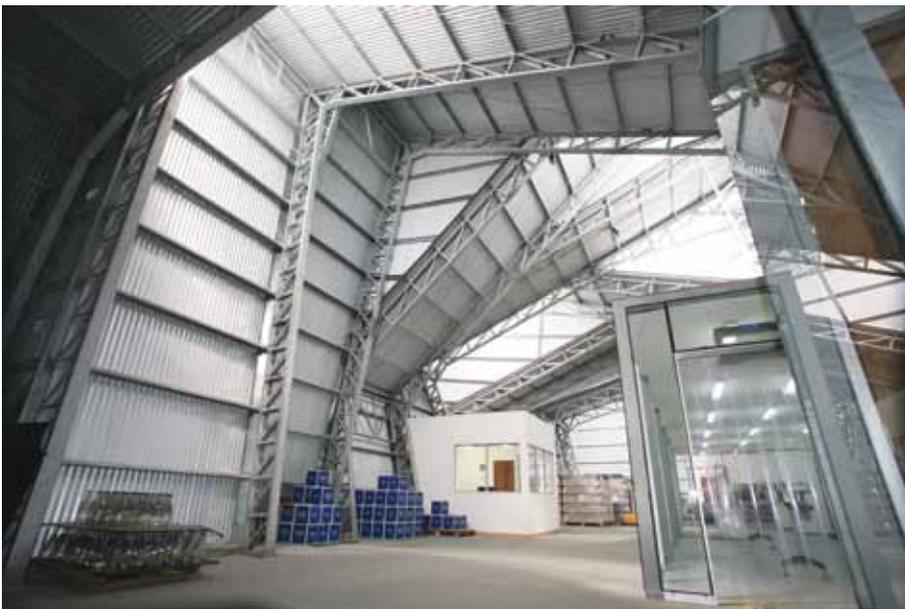
Para las paredes y cubierta se utilizó zinc-alum acanalada, según establece la norma chilena NCh2369, es un material resistente para condiciones climáticas extremas.
