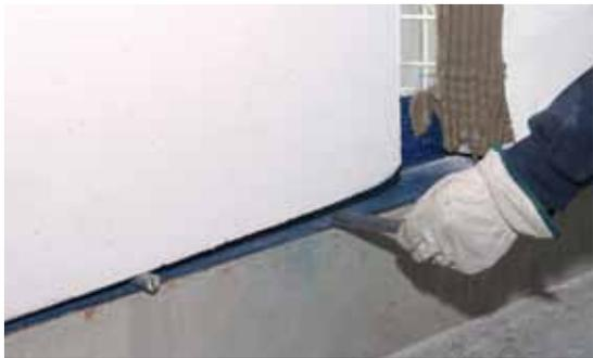
Se utilizan dos polines de fierro en la base de la estructura que ayudan al movimiento del panel. Luego se levanta el panel, haciendo palanca, para ubicar dos tacos de poliestireno dejando dilatado el panel de la base.
