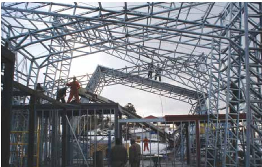
Las cerchas pasaron por un proceso de galvanizado en caliente y frío con el objetivo de evitar la corrosión en el acero.
