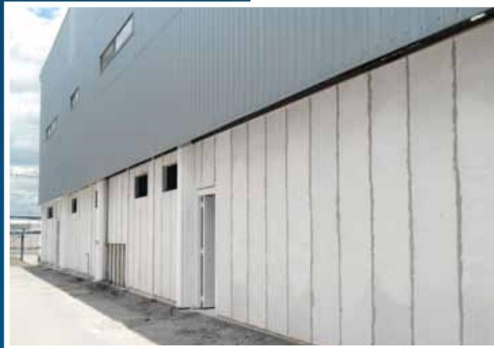
Otro ejemplo de bodega en la comuna de Quilicura, pero con los paneles en forma vertical. Con una modulación de hasta 3 m de longitud, según sus fabricantes, se haya en el mismo módulo del acero (6 m), lo que le permite estar dentro el módulo estándar, transformándolo en alternativa para este tipo de construcción.
