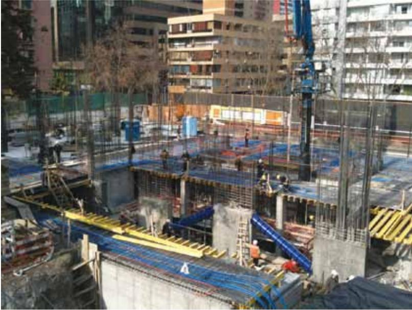
Las losas de todos los subterráneos hasta el primer piso, son losas postensadas de 21 cm de espesor con capiteles.
