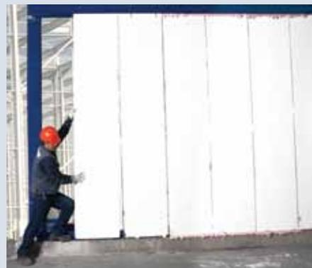
En el pegado de los paneles se deberá aplicar adhesivo en el área lateral del muro para juntarlo con el panel que continúa. Este se aplica con una cuchara dentada del mismo espesor del panel (10 cm) hasta que reviente, dejando una capa delgada de un espesor de 2 a 4 mm. Es muy importante que el adhesivo reviente entre cada junta para asegurar su correcta aplicación.
