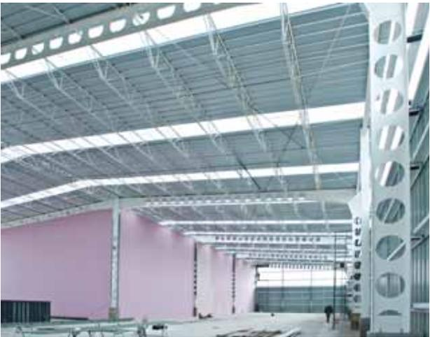
Etapa final del proyecto Los Boldos con el sistema y sus puntales instalados. En este sitio, destacan las vigas en base a estructuras livianas, la baja densidad de barras en el techo y la iluminación natural.
