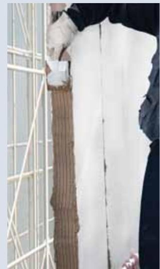
Una vez que se ubicó el panel, se retiran los polines de fierro y se inyecta espuma de poliuretano en la base y parte superior de los paneles con la estructura. Finalmente, cuando la espuma se ha secado, se debe retirar el excedente, tanto en la parte superior como inferior.
