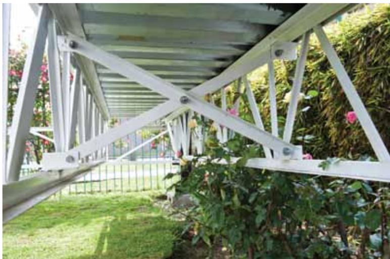
El sistema aplica un “bridging” diagonal que consiste en un elemento cruzado de arriostramiento, entre vigas superiores a 12 m de largo, con la finalidad de entregar estabilidad en la etapa de montaje.
