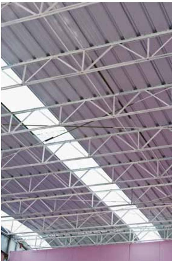
Instalación bajo una cubierta translúcida con vigas de alma abierta, que hacen posible el traspaso de la luz al interior del recinto. En cambio, una viga maciza, con acero en el centro del manto, se denomina viga de alma llena y produce el efecto contrario.
