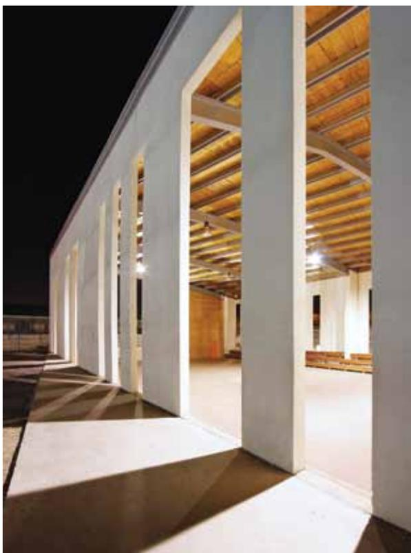
La estructura es de hormigón armado de 20 cm de espesor en base a muros verticales.
