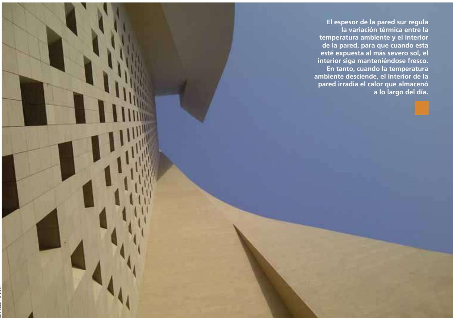
El espesor de la pared sur regula la variación térmica entre la temperatura ambiente y el interior de la pared, para que cuando esta esté expuesta al más severo sol, el interior siga manteniéndose fresco. En tanto, cuando la temperatura ambiente desciende, el interior de la pared irradia el calor que almacenó a lo largo del día.
