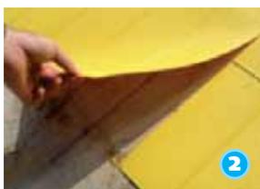
**2.** Una vez puesta sobre la superficie, la lámina actúa como molde, marcando el hormigón con textura y forma.
