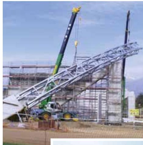
Para la construcción de cubierta, se anclarán en las fundaciones, cuatro estructuras de acero galvanizado que en su totalidad estarán revestidas de aluminio compuesto para darles la terminación.
