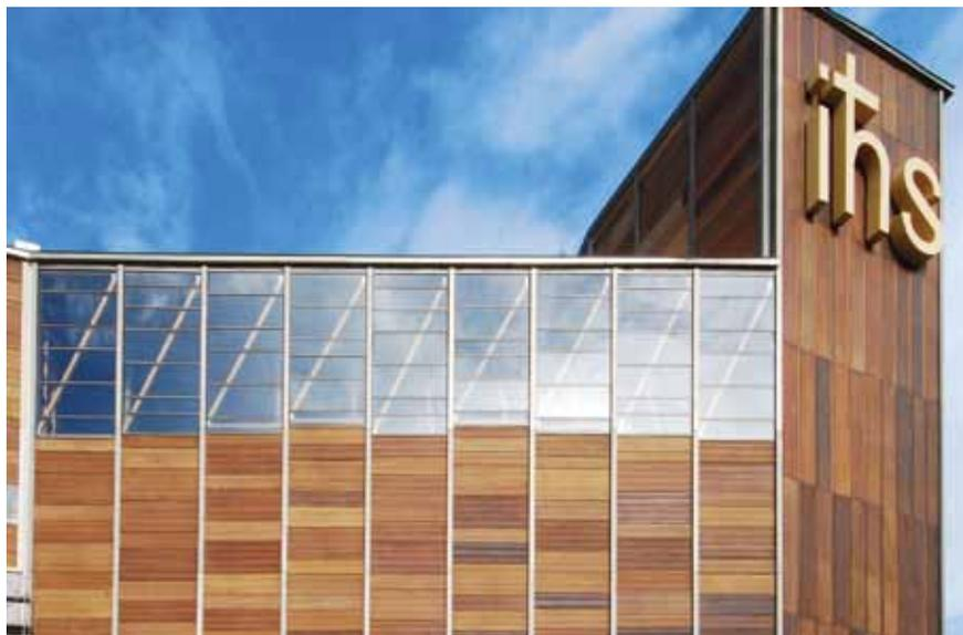
El edificio cuenta con una piel o manto térmico que lo protege de la humedad, frío y lluvia de la zona. Para ello, se revistió el hormigón con una placa de fibrocemento tinglado en módulos de 600 x 2400 x 8 mm.
