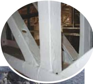
Las pinturas intumescentes se caracterizan por su dilatación al estar expuestas a altas temperaturas, generando burbujas de gas inerte que forman una barrera aislante que retrasa la propagación de las llamas, la combustión y el colapso.
