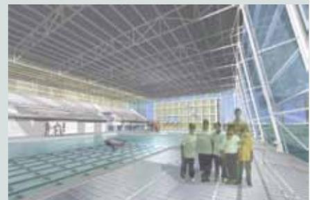
Para los cerramientos laterales de la fachada norte, sur y oriente se considera un policarbonato de 16 mm y en el poniente un revestimiento metálico, sumando una superficie de 4.500 m<sup>2</sup> de cierres. Para las playas de las piscinas, se usará una baldosa microvibrada antideslizante de 40x40 cm para 1.740 m<sup>2</sup> de superficie.
