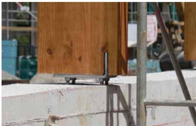
Las cerchas o marcos se armaron en el piso y posteriormente se levantaron. Asimismo se fijaron con herrajes de acero al hormigón por medio de pernos de anclaje con adhesivo epóxico.
