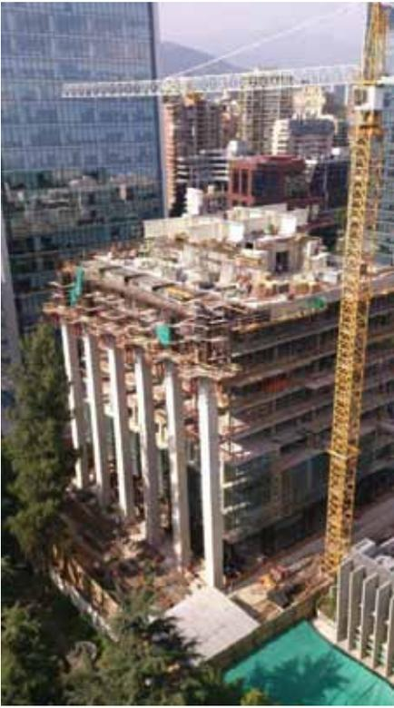
El edificio se encuentra a seis metros del suelo y se apoyará por marcos externos compuestos por columnas de hormigón y vigas metálicas superiores, las que a través de cables (columnas metálicas invertidas a la tracción), sostienen las losas de cada piso.
