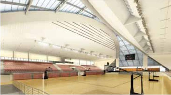
La geometría cóncava del centro deportivo permite lograr una superficie libre de elementos soportantes, mediante estos dos arcos que conforman una cúpula traslúcida de policarbonato alveolar, que, según sus desarrolladores, permite autonomía en iluminación y control de la temperatura interior.
