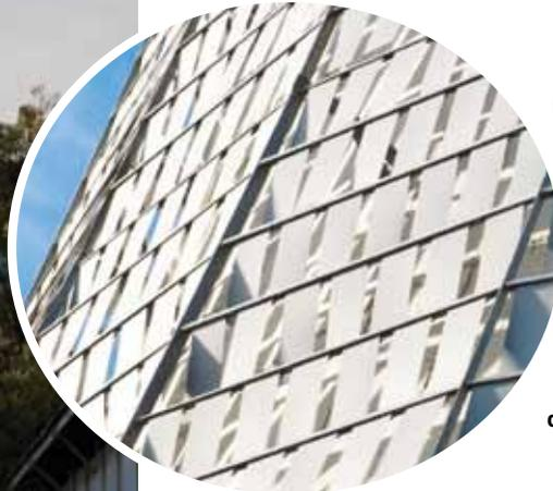
Las láminas están cubiertas de pintura que ayuda a evitar el proceso de oxidación y el paso del tiempo. En tanto, la distancia entre las láminas y el muro de hormigón de la copa es de 50 cm.
