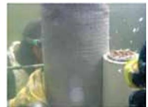
El uso de fibra de carbono y fibra de vidrio se ha transformado en una alternativa para la recuperación estructural de muelles en Norteamérica. En el caso que se aprecia en la secuencia fotográfica, todos los pilotes se reforzaron desde la zona inferior de las vigas hasta un mínimo de 60 cm bajo la zona tidal (zona que se moja y se seca conforme sube y baja la marea, dos veces al día). La instalación de tela de fibra bajo agua fue ejecutada por buzos certificados.
