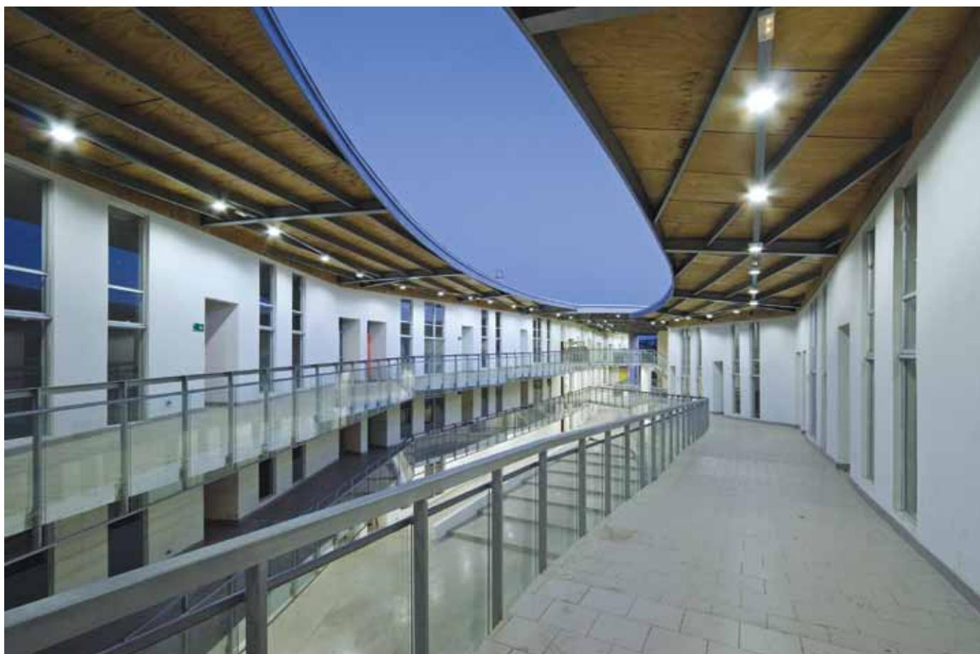
La inclusión de rampas al interior del colegio le da una estructura completamente ortogonal. El moldaje usado para estas fue tradicional con guías laterales.
