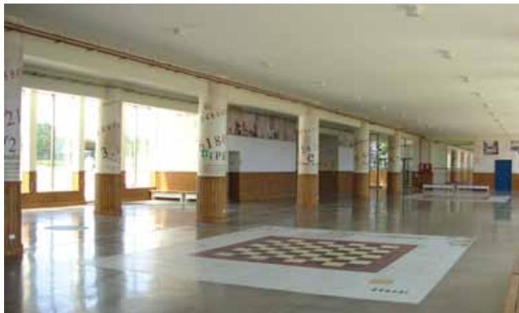
Para el piso del colegio, la constructora usó el mismo hormigón, la diferencia es que le realizaron un proceso de pulido que permite una superficie lisa, con brillo y de fácil mantención.
