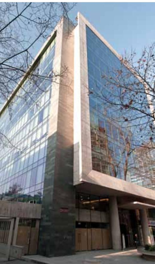
**Los cristales soft coat son de alta eficiencia energética reduciendo gastos en iluminación artificial, calefacción y aire acondicionado, razón por la que ya se usan en fachadas como la del edificio La Concepción, en Providencia.**
