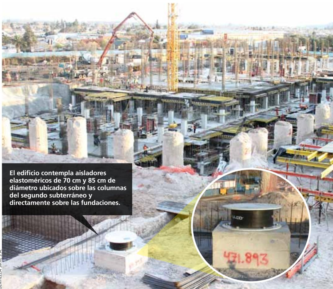
El edificio contempla aisladores elastoméricos de 70 cm y 85 cm de diámetro ubicados sobre las columnas del segundo subterráneo y directamente sobre las fundaciones.
