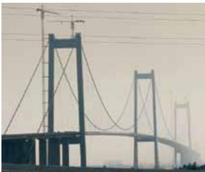
La construcción, que tuvo un costo de US\$ 650 millones, cruza el río Yangtze en la provincia de Jiangsu, cuenta con tres pilas y la altura de sus torres alcanza los 178, 194 y 178 m respectivamente. El vano principal es de 1080 m y el largo total del puente es de 9.726 m.
