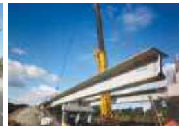
28 ESTRUCTURAS RUTA 5 SUR PUERTO MONTT - PARGUA
