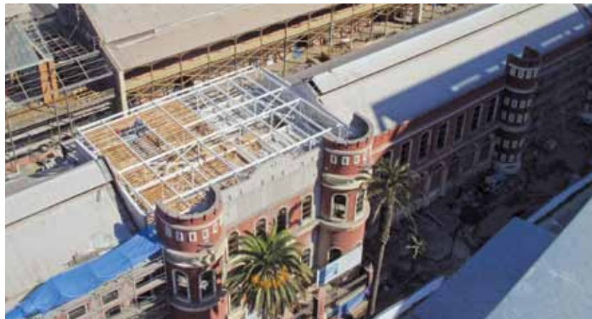
El primer paso de la recuperación del Edificio Ex Arsenales de Guerra se centró en reforzar la estructura, ya que varios de los muros de albañilería de ladrillo se desaplomaron y en algunos casos se agrietaron.
