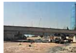
VIGAS PUENTE COSTANERA CENTER
