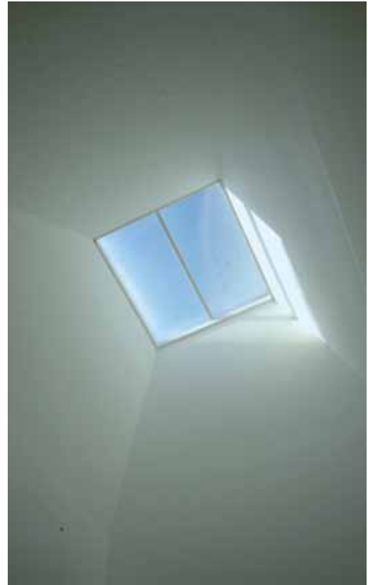
La cubierta cuenta con una lucarna a fin de reducir el consumo de iluminación artificial.
