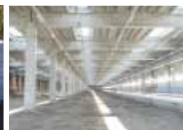
TALLERES Y COCHERAS SAN EUGENIO - METRO LÍNEA 6
