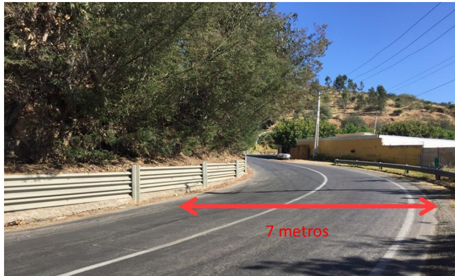
Segunda etapa ejecutada en diciembre 2016
